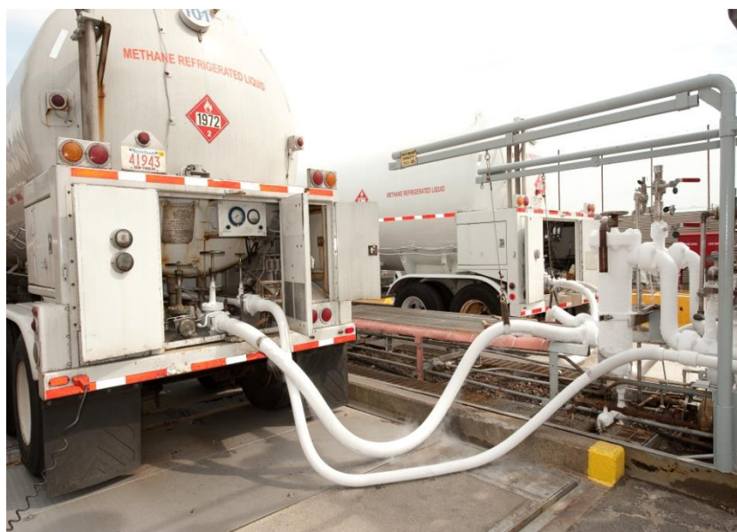
Figura 7. Cisterna de GNL y regasificación Fuente: Cervantes (2018)
