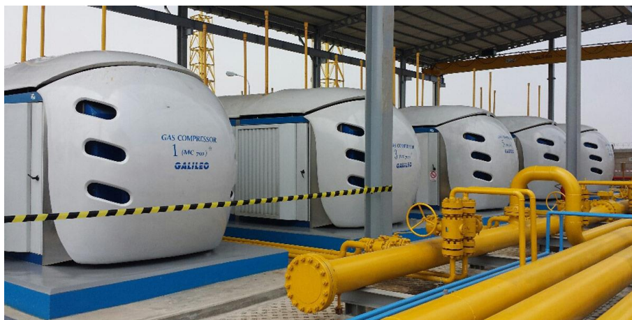
Figura 9. Módulos de compresión de gas natural comprimido en Gran Yakarta. Fuente: Galileo Technologies (2014).
