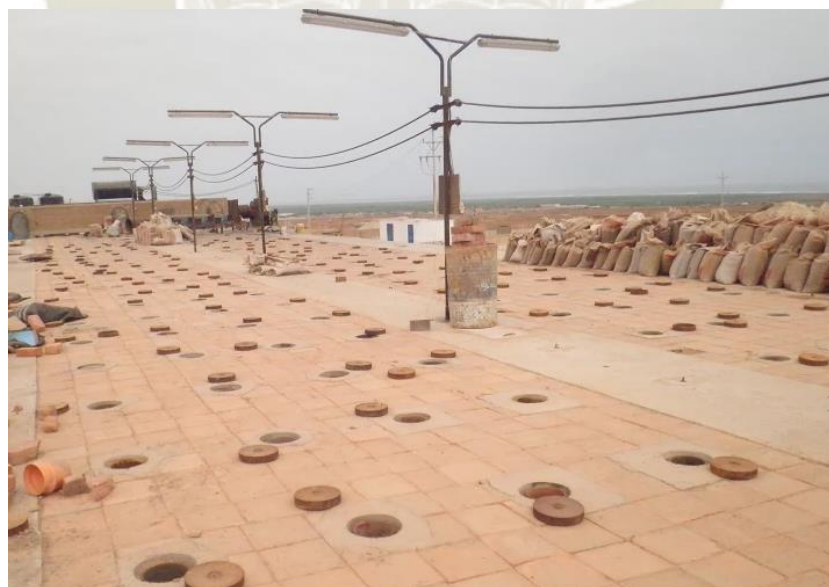
Figura 27. Distribución de los orificios para quemadores
