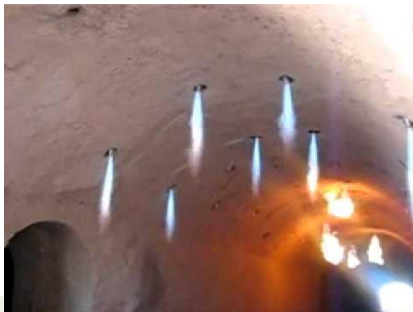
Figura 28. Funcionamiento de quemadores dentro de Horno Hoffmann invertido Fuente: Elaboración Propia
