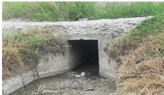
Figura 1: Ventana de ingreso al canal de conducción. Elaboracion: El Autor.
