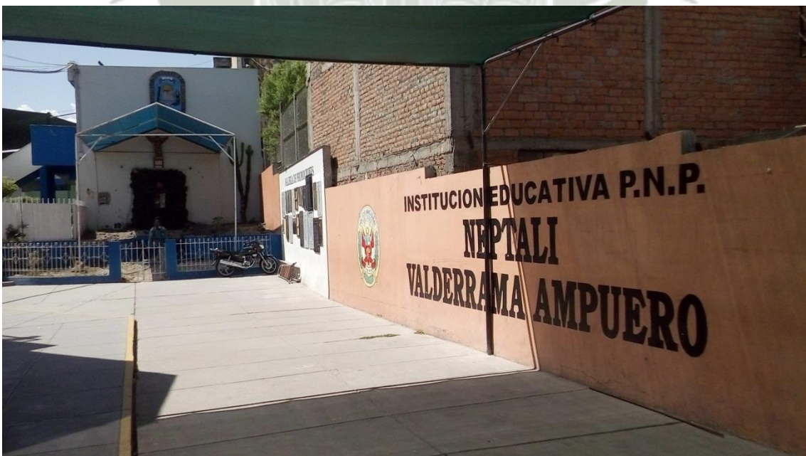
Imagen Nro 2: Instalaciones interiores del Colegio.
