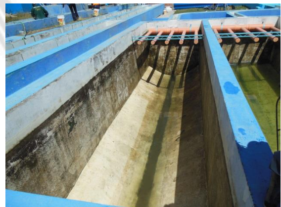
DECANTADORES DE FLUJO HORIZONTAL EN CONDICIONES DE OPERACIÓN Y LIMPIEZA
