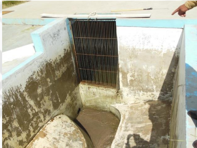
OBSERVACIÓN SOBRE LA VENTANA DE INGRESO A LA CISTERNA
