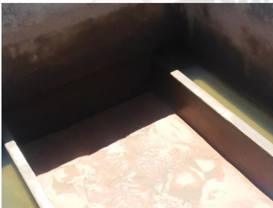
MATERIAL DEL LECHO FILTRANTE ARRASTRADO DURANTE EL PROCESO DE LAVADO
