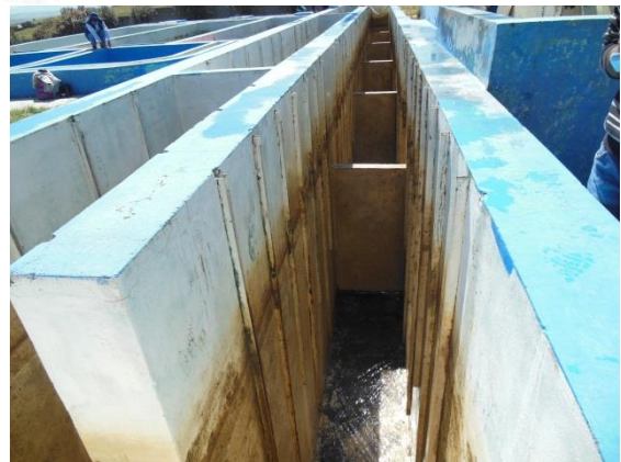
FLOCULADOR DE PANTALLAS DE FLUJO VERTICAL
