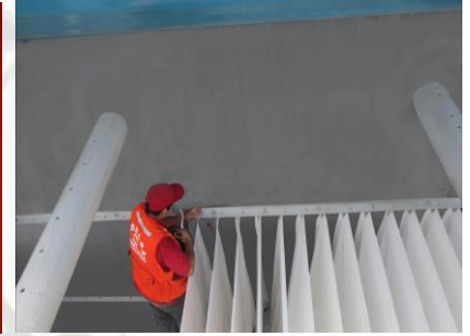
INSTALACION EN OBRA
