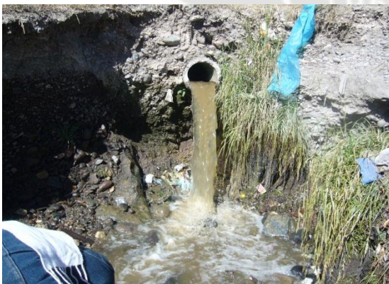
DESCARGA DE AGUAS RESIDUALES SIN TRATAMIENTO EN EL RIO CAÑIPIA
