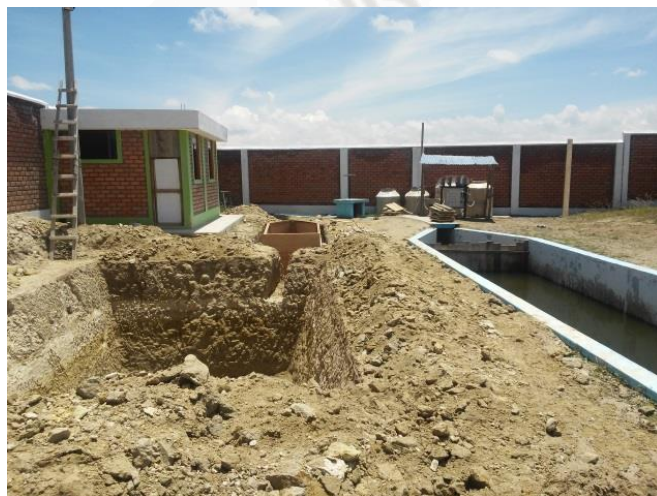
CONSTRUCCIÓN DE NUEVO DESARENADOR
