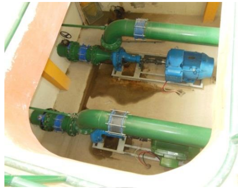
DESARENADOR Y BOMBAS CENTRÍFUGAS INSTALADAS EN LA ESTACIÓN DE BOMBEO
