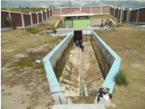
DESARENADOR Y BOMBAS CENTRÍFUGAS INSTALADAS EN LA ESTACIÓN DE BOMBEO
