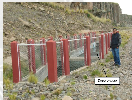
BOCATOMA Y DESARENADOR DEL SISTEMA DE CAPTACIÓN – RÍO APURÍMAC
