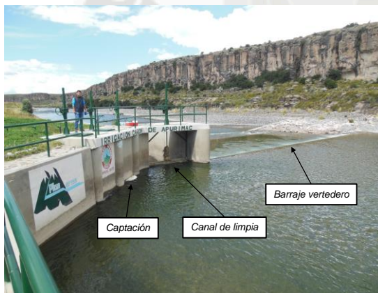
BOCATOMA Y DESARENADOR DEL SISTEMA DE CAPTACIÓN – RÍO APURÍMAC
