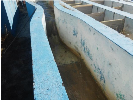
NO SE PRODUCE UN RESALTO EN LA GARGANTA DE LA CANALETA PARSHALL
