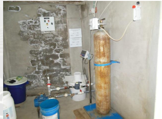
DERECHA: SISTEMA DE DESINFECCIÓN DE LA PLANTA DE TRATAMIENTO IZQUIERDA: SISTEMA DE DESINFECCIÓN EN LOS RESERVORIOS DE LA RED
