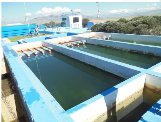
DECANTADORES DE FLUJO HORIZONTAL EN CONDICIONES DE OPERACIÓN Y LIMPIEZA
