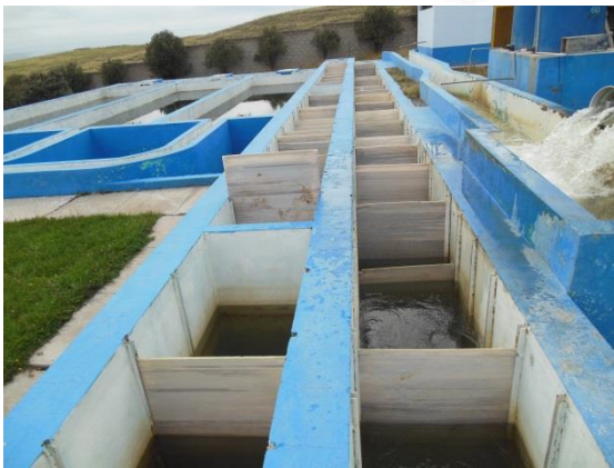
FLOCULADOR DE PANTALLAS DE FLUJO VERTICAL
