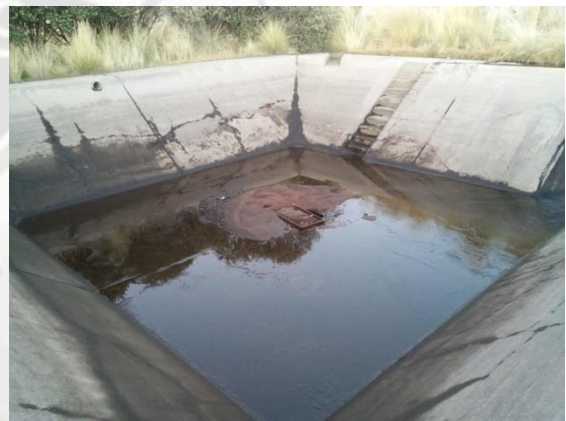
MATERIAL DEL LECHO FILTRANTE ARRASTRADO DURANTE EL PROCESO DE LAVADO
