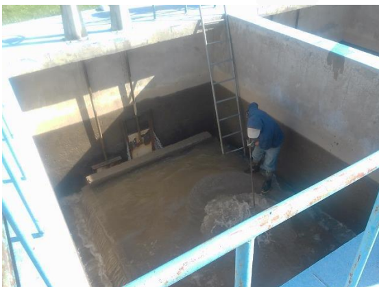
LAVADO DE UNA DE LAS UNIDADES DE FILTRACIÓN, Y HERRAMIENTAS PARA MEDIR EL TIEMPO DE LAVADO ÓPTIMO
