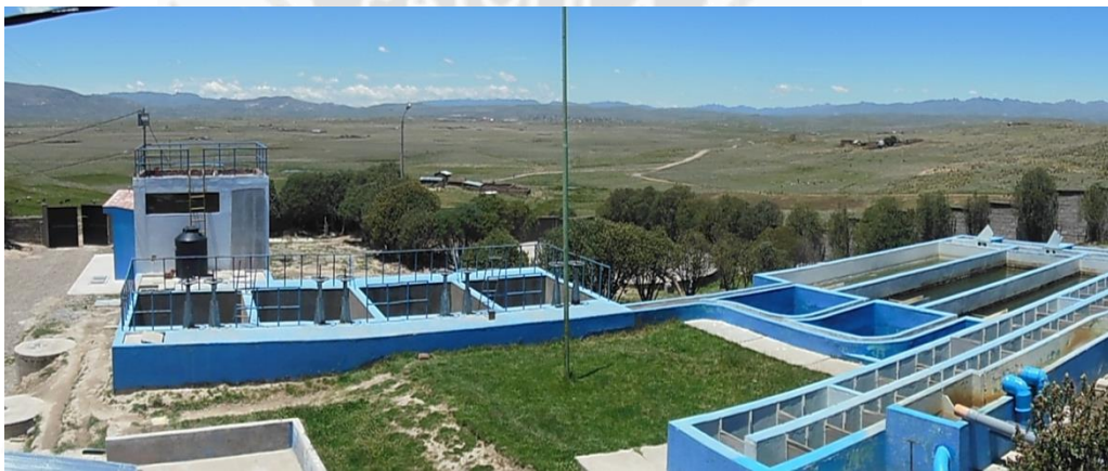
PLANTA DE TRATAMIENTO DE TECNOLOGÍA CONVENCIONAL, QUE TRATA UN CAUDAL DE 95 L/S PROVENIENTES DEL RÍO APURÍMAC
