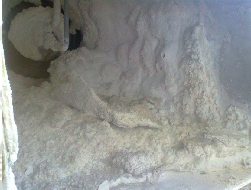
Imagen 4.10. Ducto de chimenea
