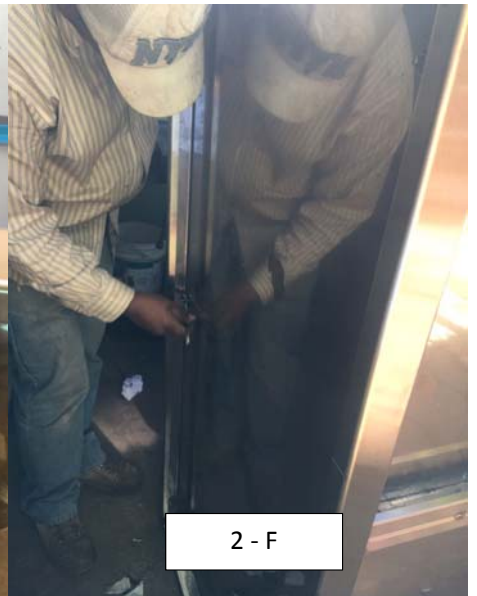
2D, 2E, 2F Armado y Plegado de las Planchas de Acero Inoxidable
