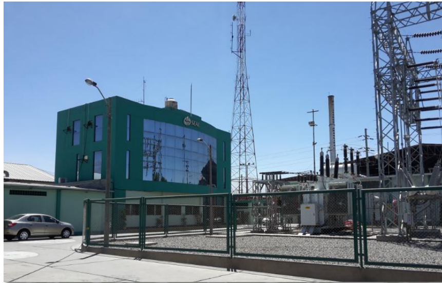
Figura 4. Frontis de la sede de Parque Industrial
