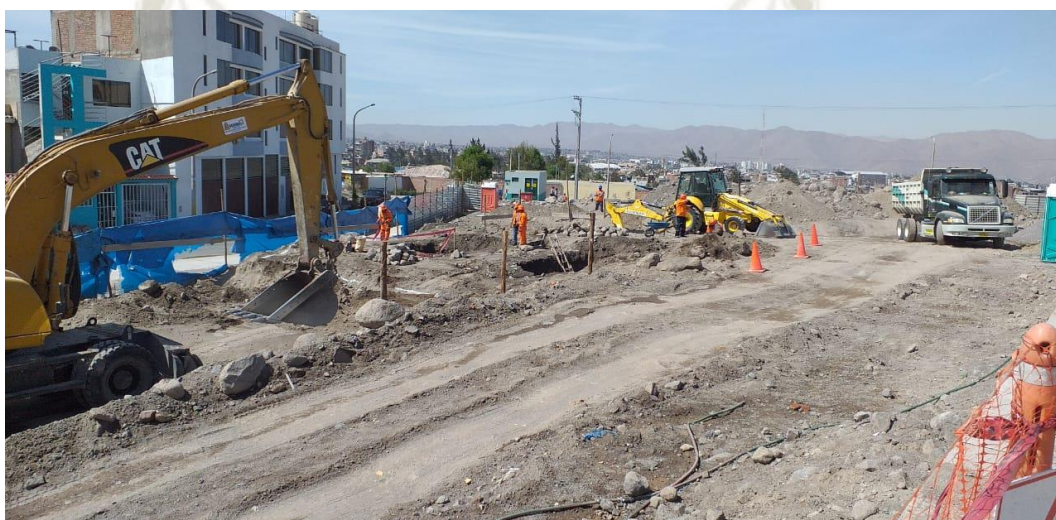
Figura 22 Excavación masiva
