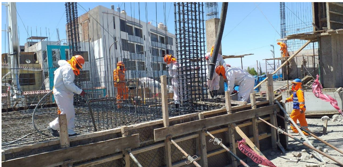
Figura 33 Vaciado de concreto en zapatas
