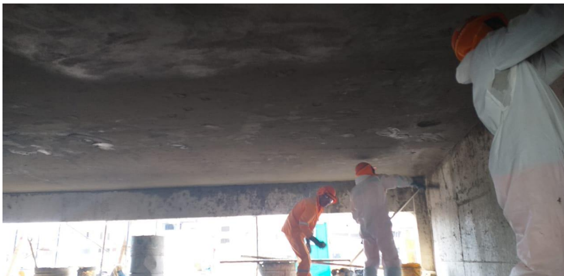
Figura 41 Tarrajeo de cielo raso
