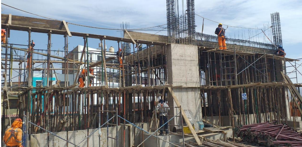
Figura 25 Encofrado doble nivel de la losa S5N1
