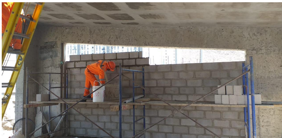
Figura 39 Colocación de King block en diagonal
