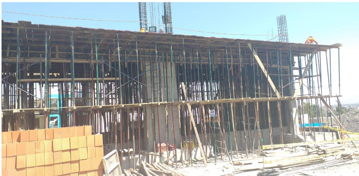
Figura 35 Encofrado doble de losa del S5N1
