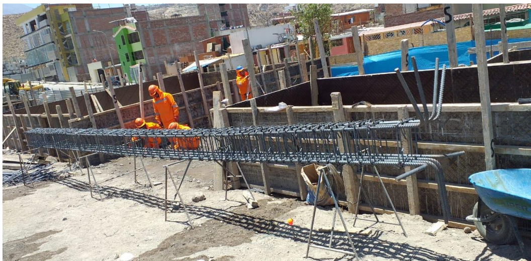
Figura 23 Armado de acero en el frente B
