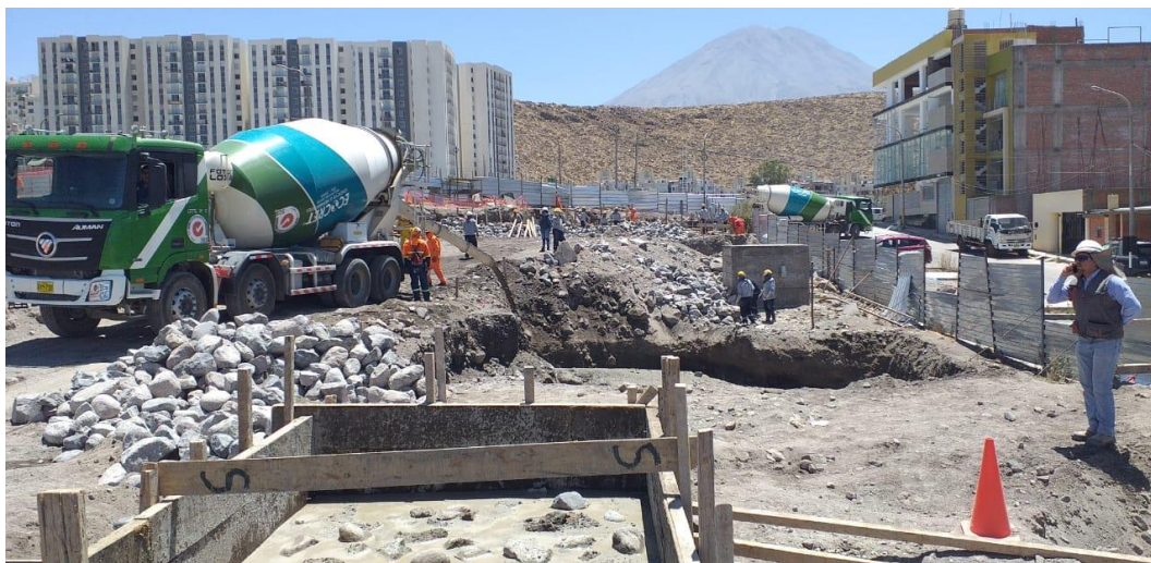
Figura 26 Vaciado de concreto ciclópeo en sub zapatas
