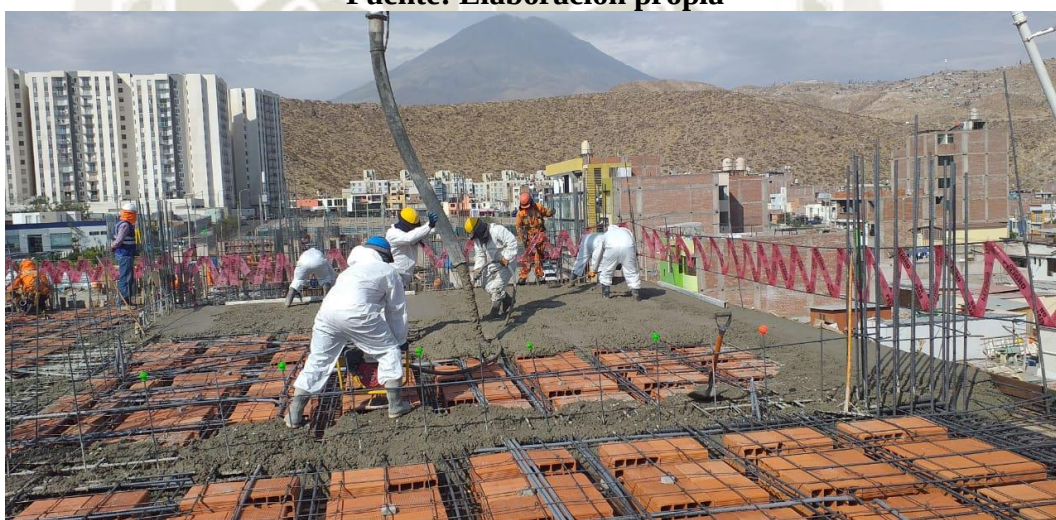
Figura 27 Vaciado de concreto de losa S5N2
