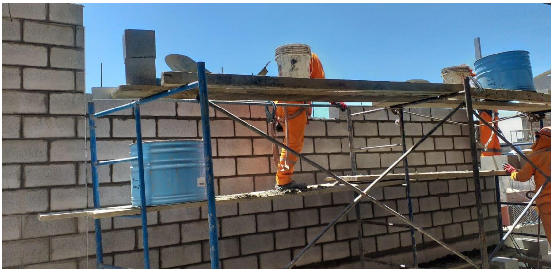
Figura 40 Colocación de King block exteriores
