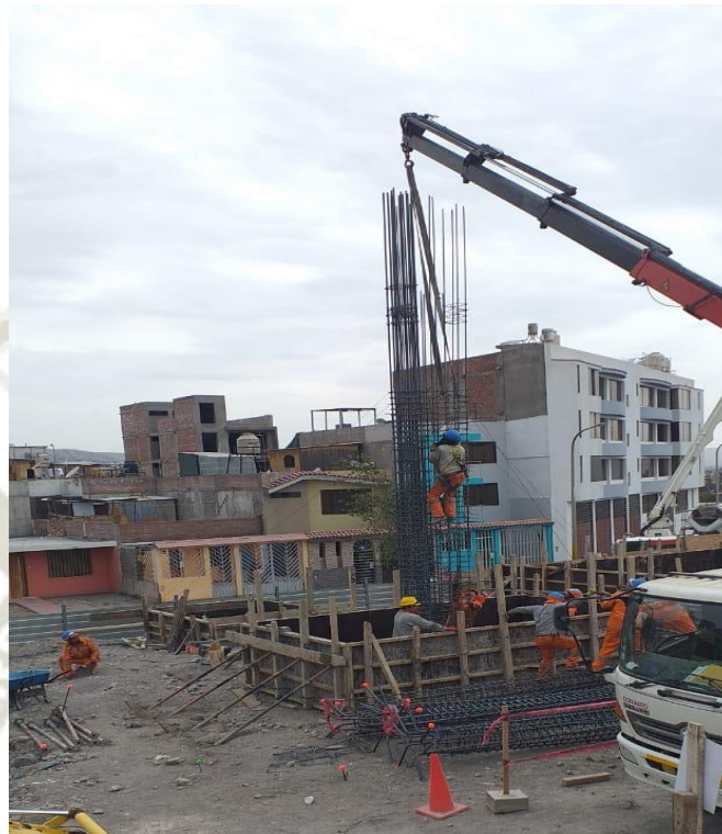
Figura 31 Izaje de elementos de acero
