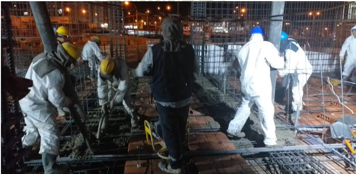
Figura 38 Vaciado de concreto de la losa del S2N1
