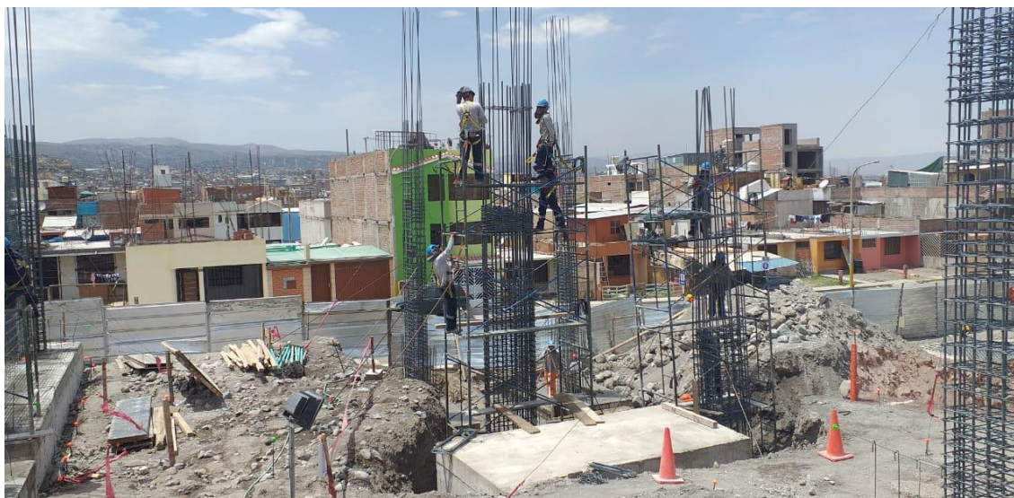
Figura 32 Armado de acero in situ
