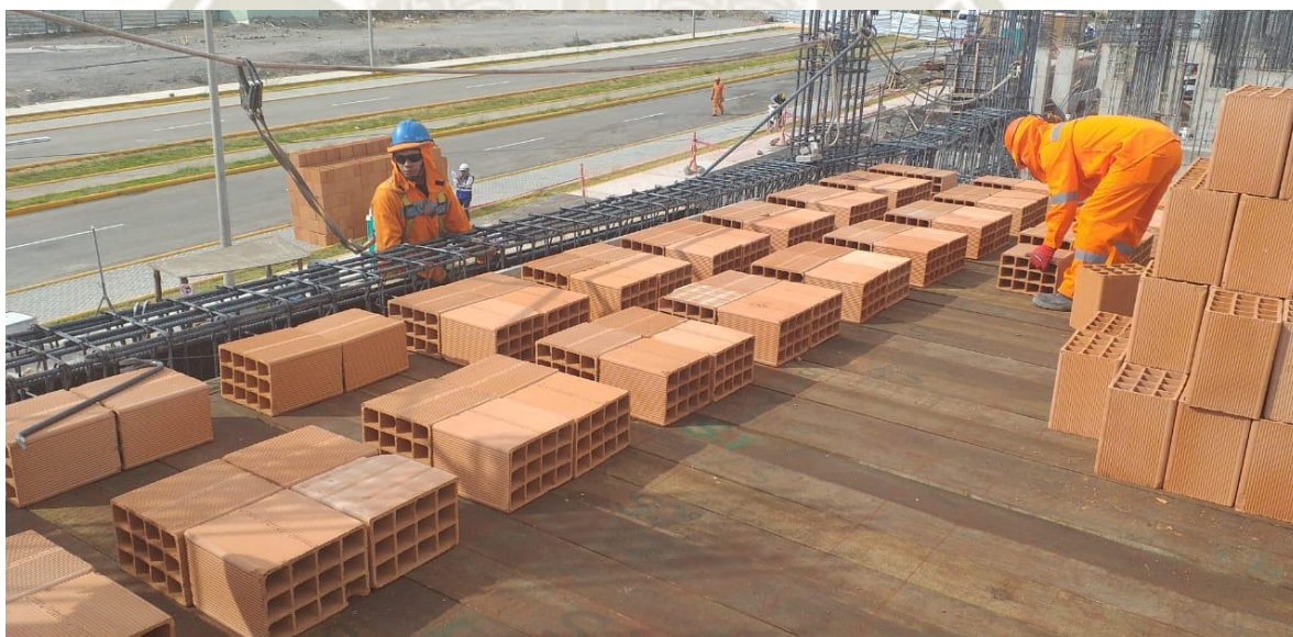
Figura 36 Colocación de ladrillos de la losa del S5N1
