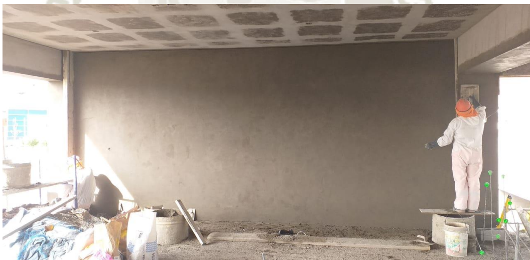
Figura 29 Tarrajeo de muro eje 3 S2N2
