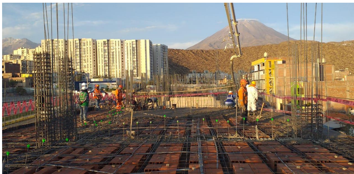
Figura 37 Vaciado de concreto de la losa del S5N1
