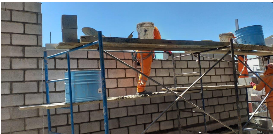
Figura 28 Colocación de King block en exteriores
