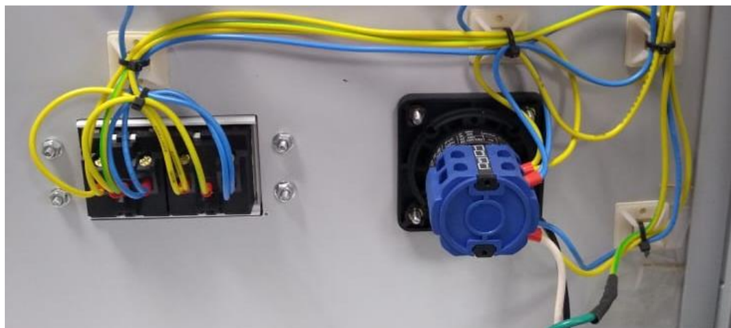
Figura 23. Derivación del interruptor general al tomacorriente doble. Fuente: Elaboración propia
