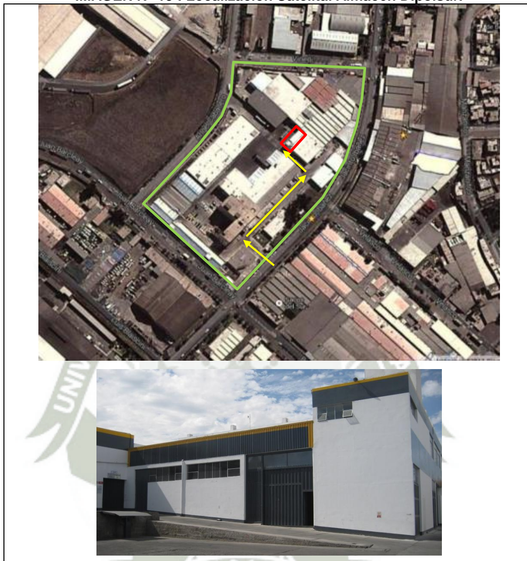
IMAGEN N° 13 : Localización Satelital Almacén Dipolsur.
