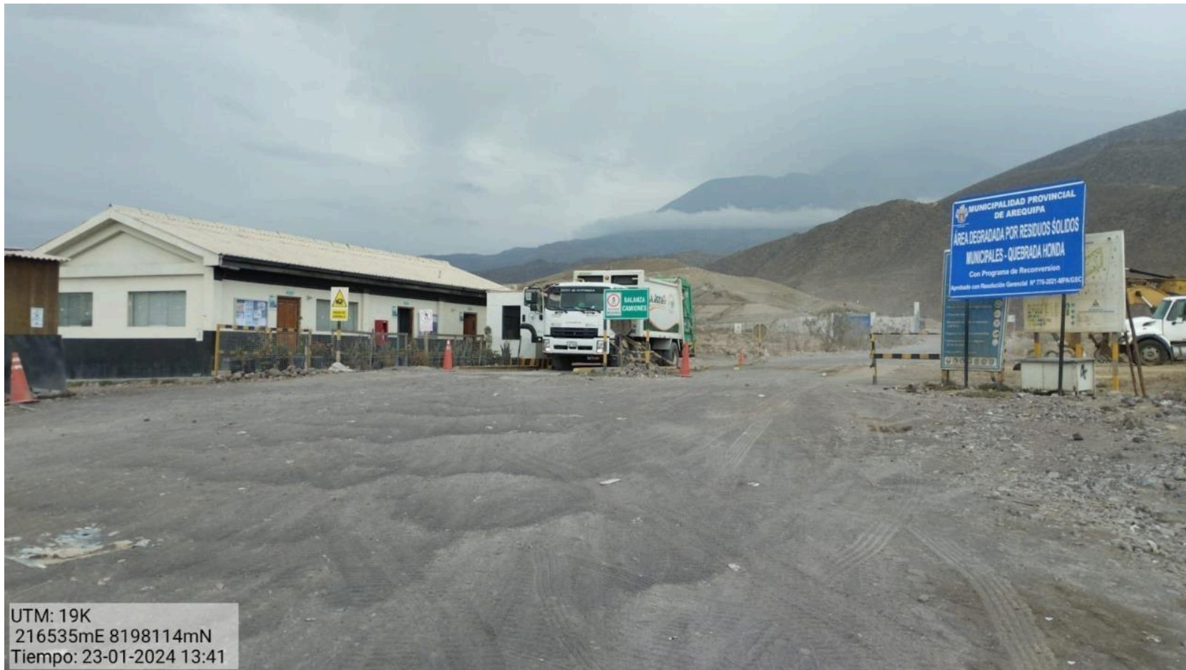
Figura N° 10. Vía de acceso al área degradada de “Quebrada Honda”; km 19, Yura – Arequipa.
