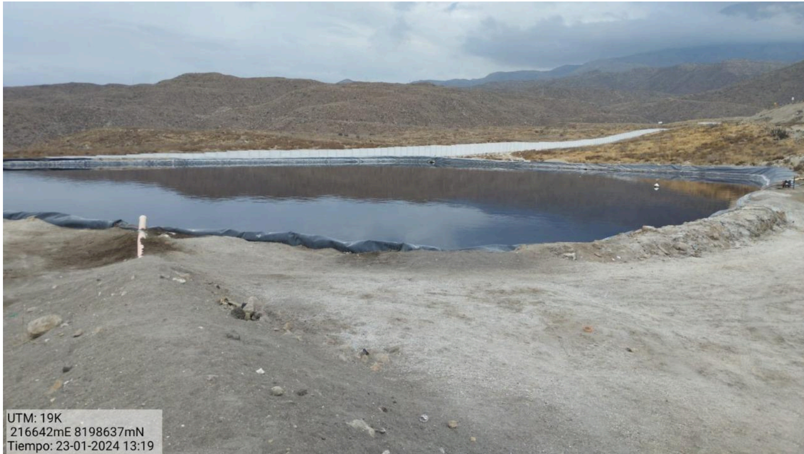
Figura N° 11. Pozo de lixiviados del área degradada de “Quebrada Honda”; km 19, Yura – Arequipa.
