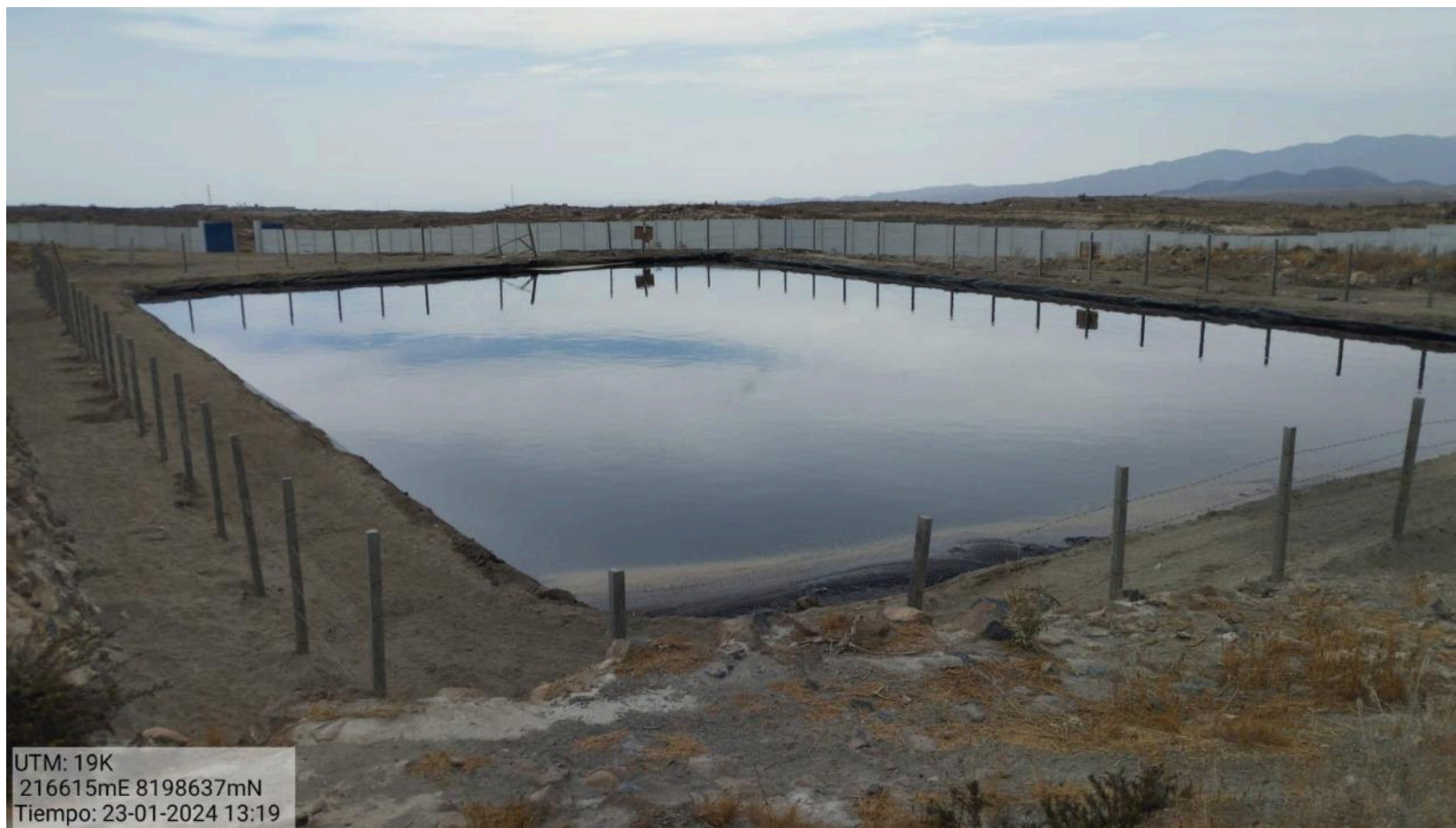
Figura N° 08. Pozo de lixiviados del Área degradada de “Quebrada Honda”; km 19, Yura – Arequipa.
