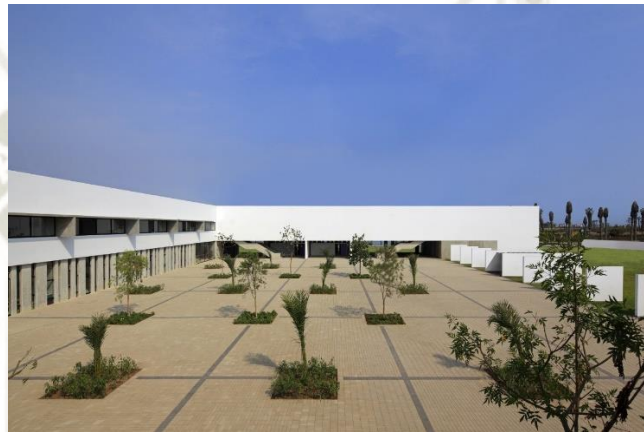
Imagen N°24, Patio interior, al lado bloque que aún no está construido.
