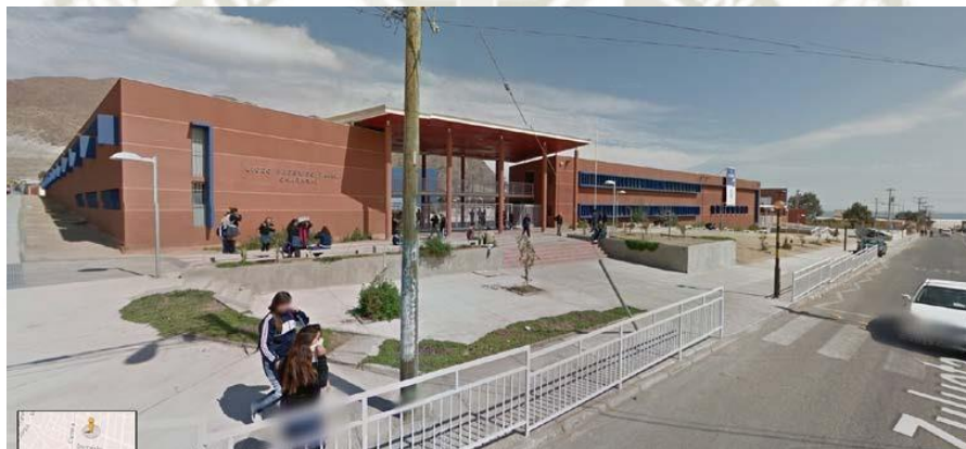
Imagen N°28, Fachada del colegio – espacio de encuentro.
