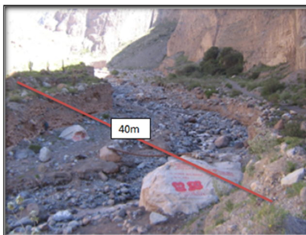
FOTO N° 1.2 LONGITUD DEL PUENTE
