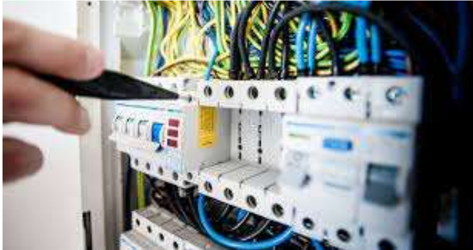
Figura 1 Mantenimiento de instalaciones eléctricas
