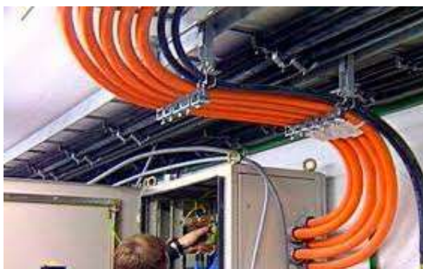
Figura 4 Mantenimiento de instalaciones eléctricas
