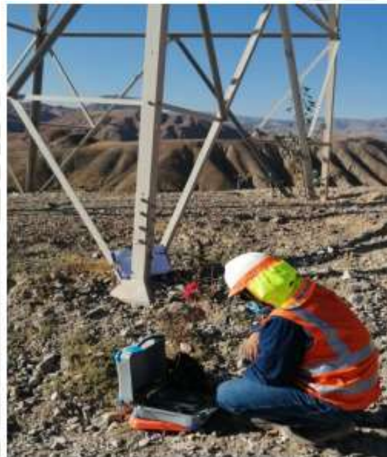
Figura 9 Medición de resistencia de puesta a tierra de torre metálica
