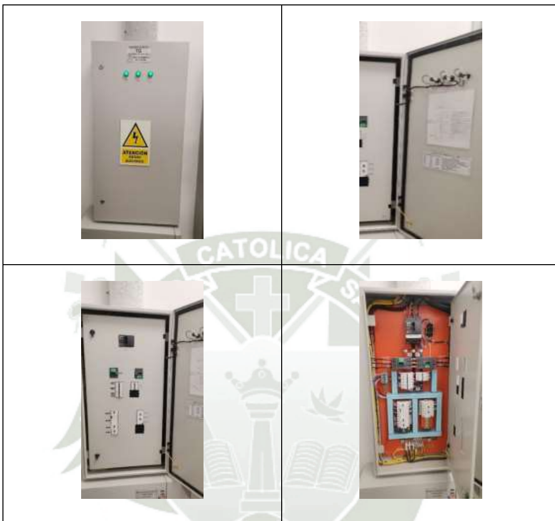
Figura 76 Estado final del Tablero TG
