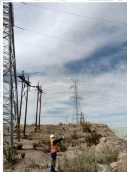
Figura 18 Registro de niveles de ruido en línea de transmisión 138 kV
