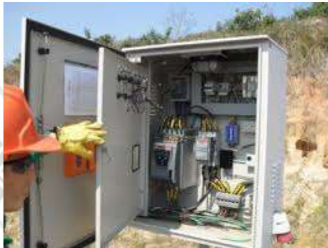
Figura 3 Mantenimiento de instalaciones eléctricas
