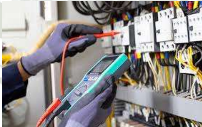
Figura 2 Mantenimiento de instalaciones eléctricas
