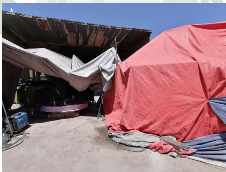
Figura 40 - Carpa para trabajo de soldadura
