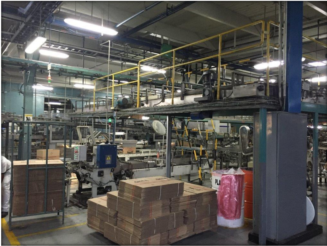
Figura 38. Fotografía de equipos de empaqueo
