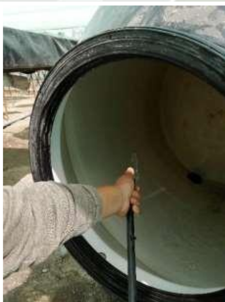
Anexo 2: Limpieza de tanque.
