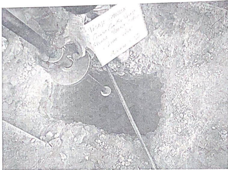
Calicata N° 2 Fotografía N° 3
