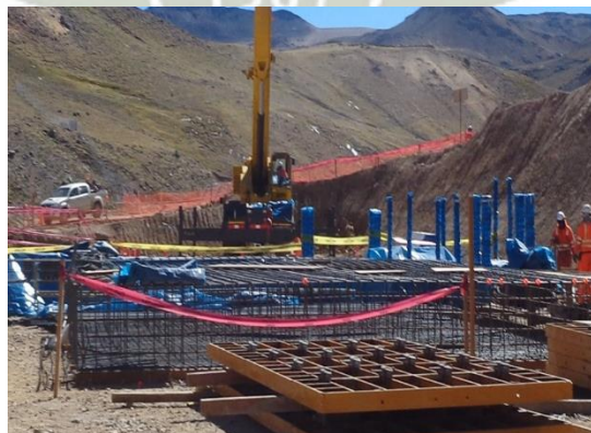
Ilustración N° 16 Pre-armado con acero estructural – para cimentación, zapatas y pedestales
