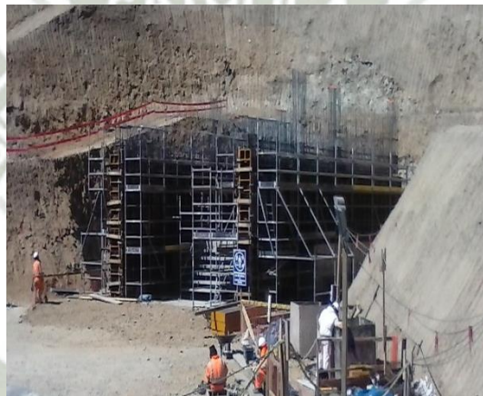
Ilustración N° 15 Pre-armado de acero estructural
