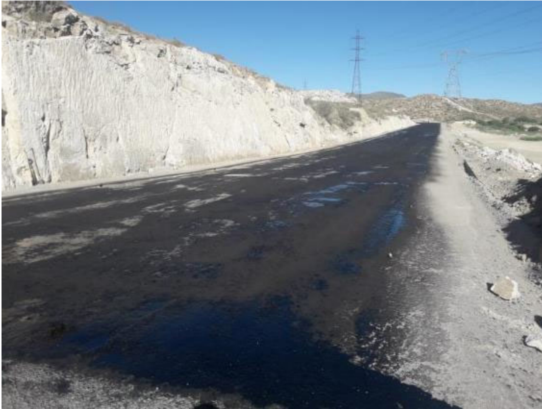
Ilustración 24 – Vía imprimada
