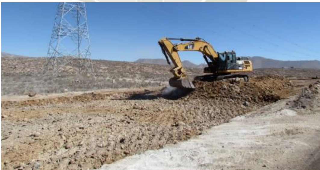
Ilustración 19 – Corte en vía con excavadora de orugas
