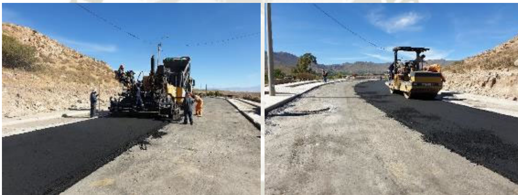
Ilustración 26 – Esparcido de capa asfáltica y compactación
