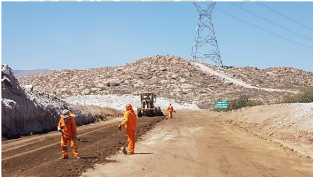
Ilustración 20 – Conformación de capa base con motoniveladora y rodillo
