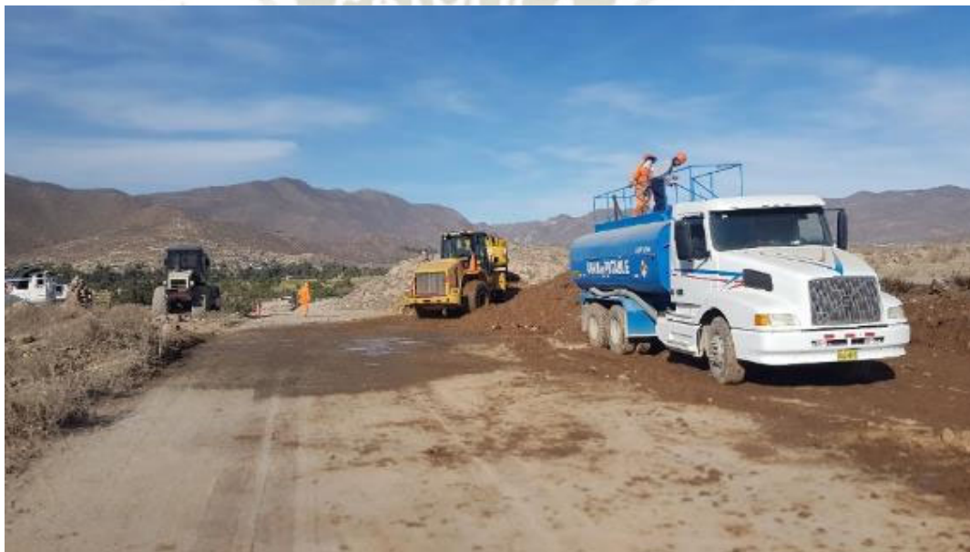
Ilustración 17 – Limpieza superficial y corte de vía con cargador frontal y cisterna
