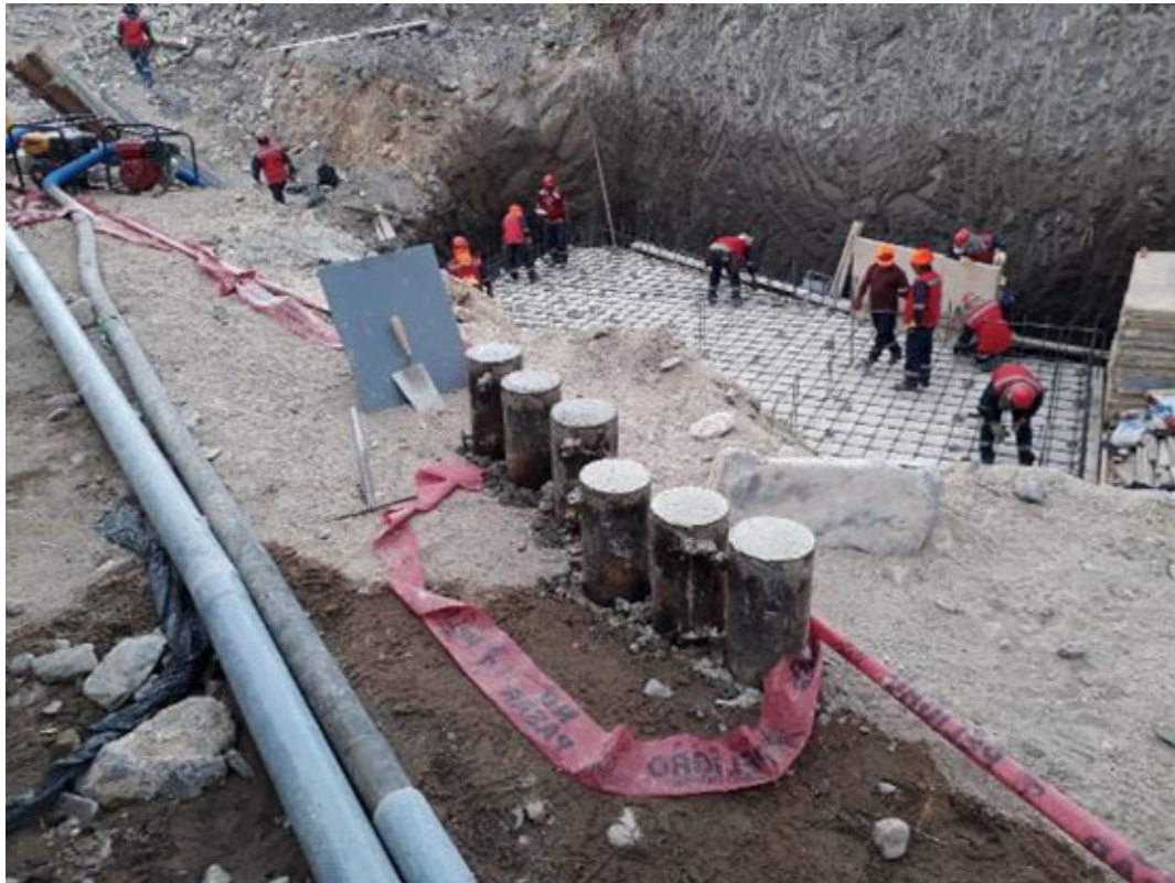
Ilustración 30 – Testigos de concreto
