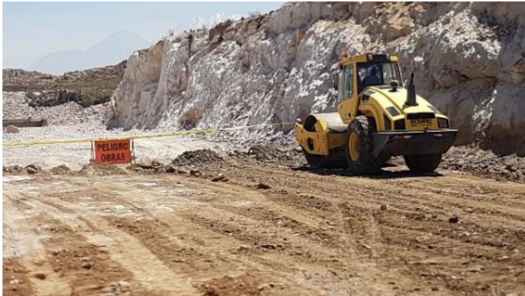
Ilustración 21 – Conformación de capa base con motoniveladora y rodillo
