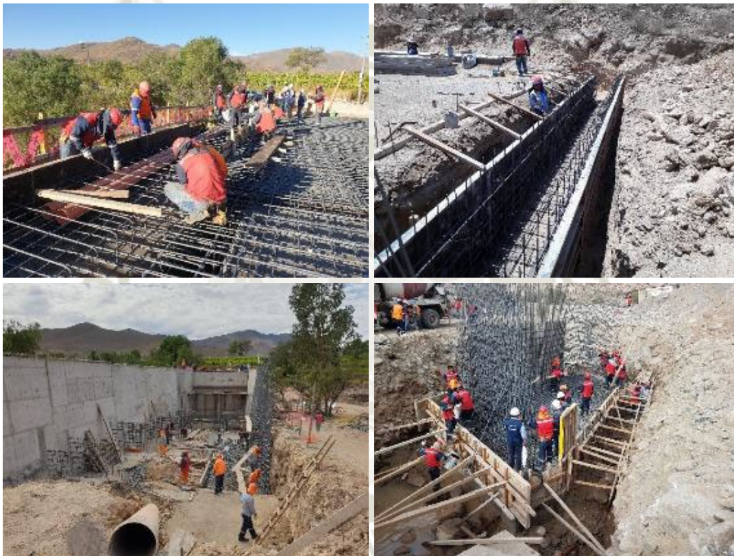
Ilustración 27 – Habilitación de acero
