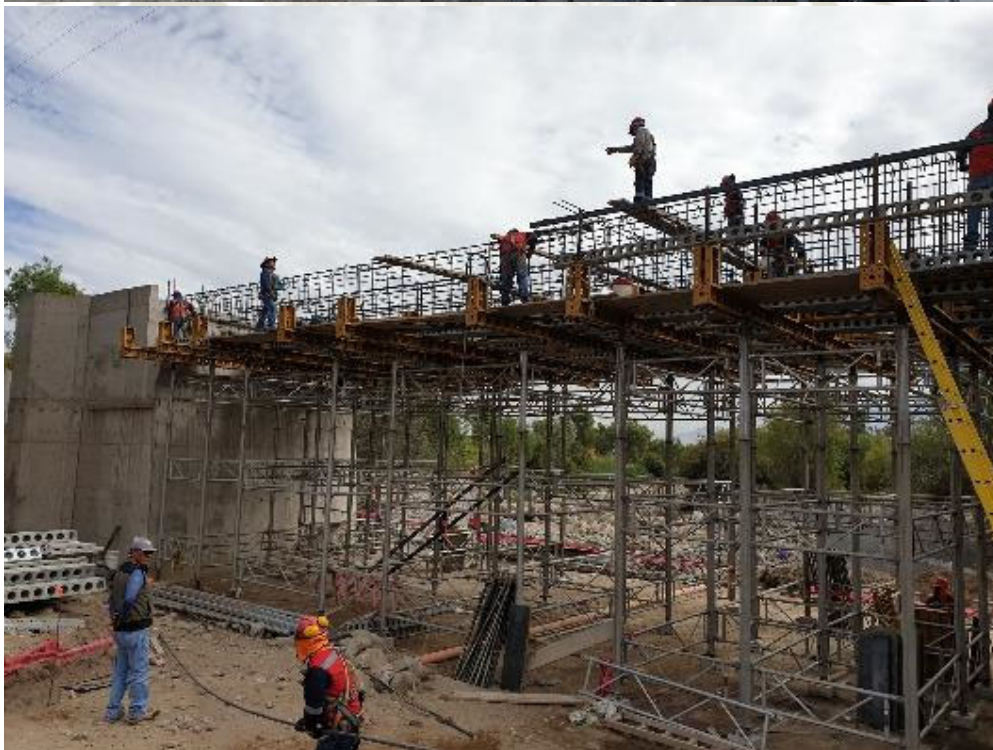
Ilustración 28 – Encofrado para estribos y falso puente para viga
