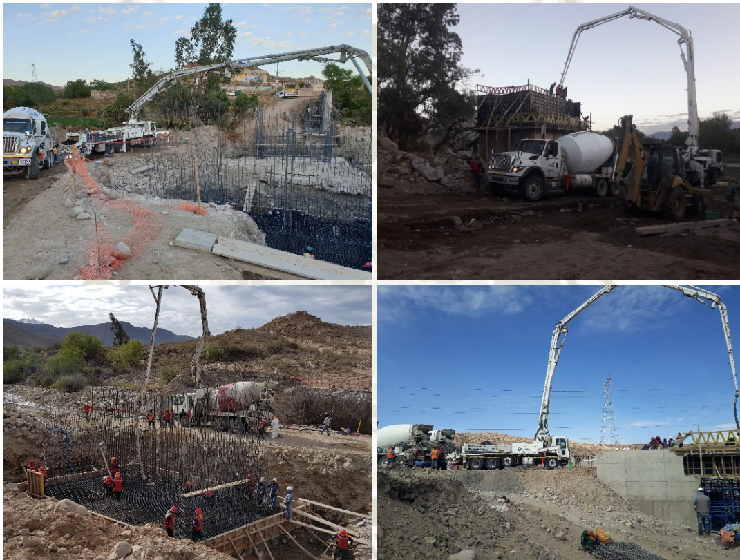
Ilustración 29 – Vaciado de concreto
