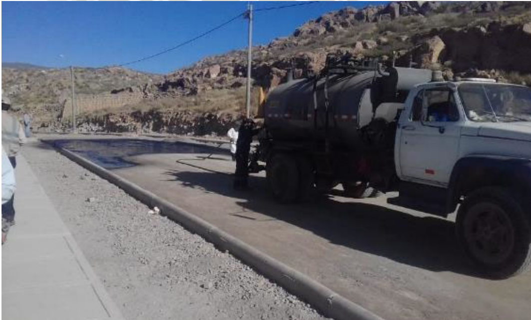
Ilustración 23 – Imprimación asfáltica con camión imprimador
