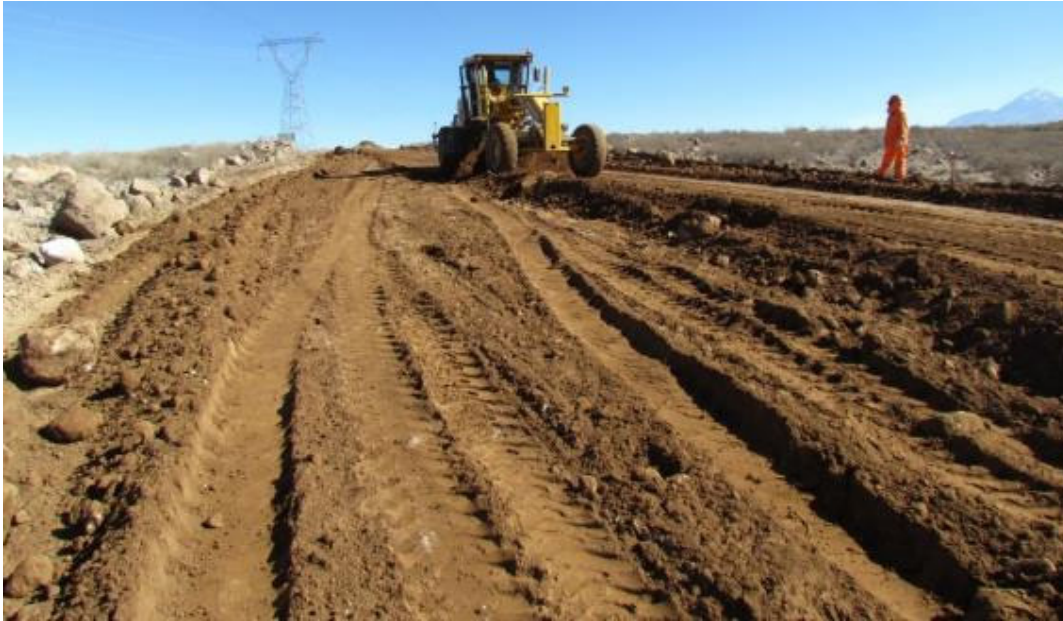
Ilustración 18 – Corte superficial con motoniveladora
