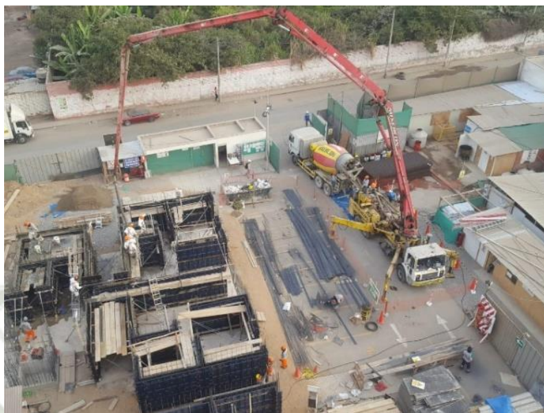
Figura 65: Proceso de encofrado y colocación de concreto en muros Fuente: Elaboración propia
