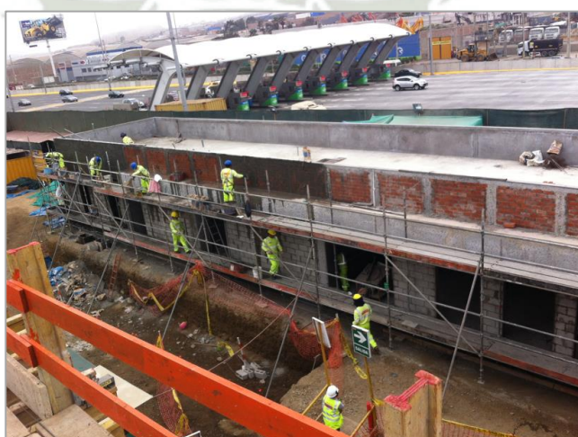
Figura 14: Proyecto “Rutas de Limas – Oficinas Villa” (COINSA SAC) – Año: 2015” Fuente: Elaboración propia
