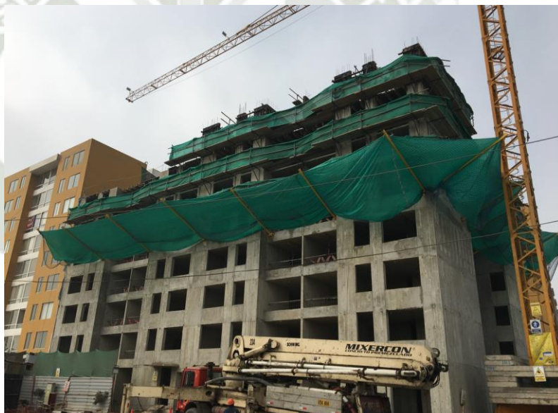
Figura 66: Proceso constructivo de muros y losas concreto armado Fuente: Elaboración propia
