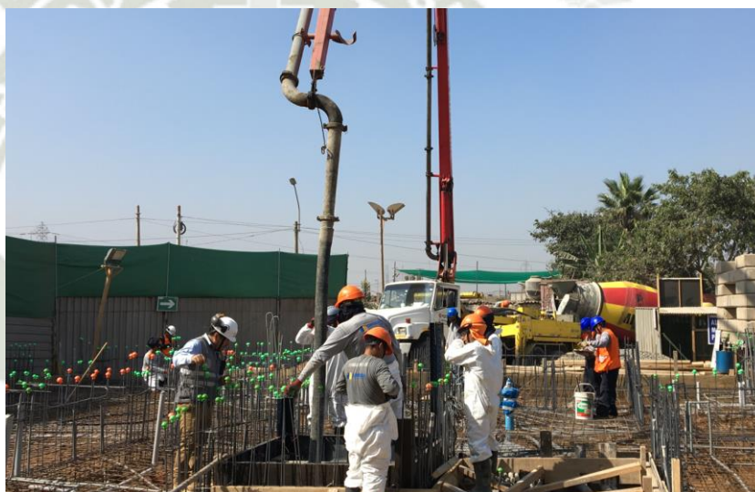
Figura 64: Proceso constructivo platea de cimentación – Colocación de concreto Fuente: Elaboración propia
