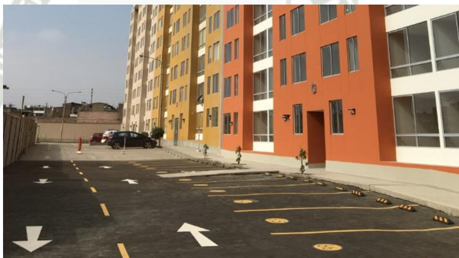
Figura 59: Área de estacionamiento “C.R. Ciudad Verde Etapa 4” Fuente: Elaboración propia
