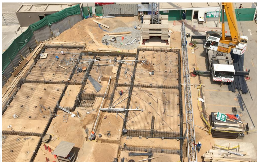
Figura 63: Proceso constructivo platea de cimentación – Excavación localizada / Acero de refuerzo Fuente: Elaboración propia
