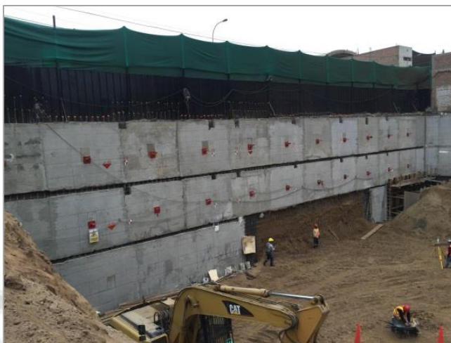
Figura 12: Proyecto “Costanera 25 – Muro Anclado Etapa 1” (WESCON SAC) – Año: 2016 Fuente: Elaboración propia
