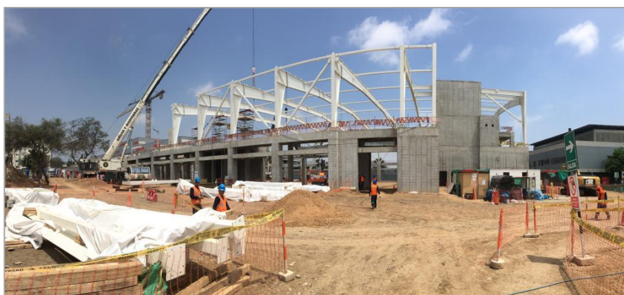
Figura 9: Proyecto “Remodelación VIDENA – Obras Exteriores” (WESCON SAC) - Año: 2018 Fuente: Elaboración propia
