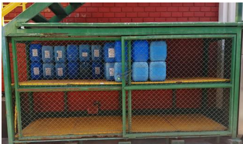
Figura 72. Lugar de almacenamiento del hipoclorito de sodio
