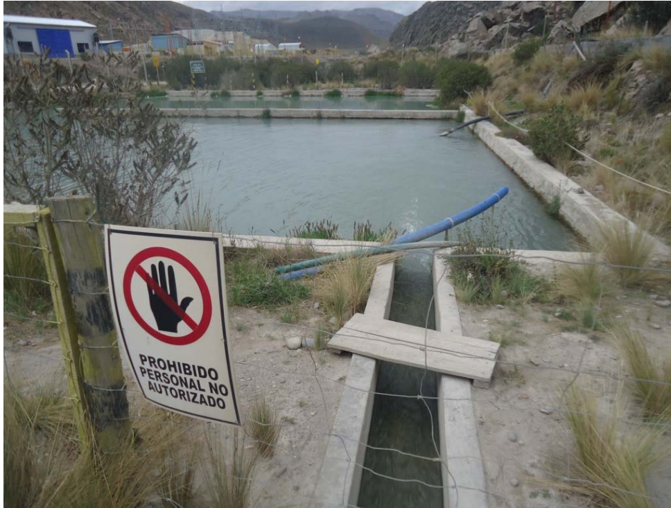
Foto 4.3 Pozas de Decantación Rampa Mario. Fuente: Propia.
