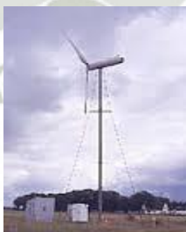
Figura 2.2: Aerogenerador con Rotor Sotavento. Fuente: Fotografía Sores Krohn 1998 DWIA.
