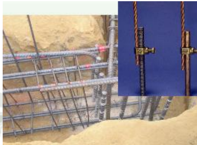
Fig. 4.11 .- Sujecion a las barras estructurales
