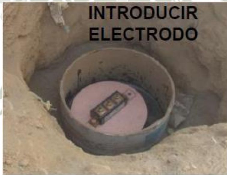
Fig. 4.9 .- Introducción del electrodo estructural
