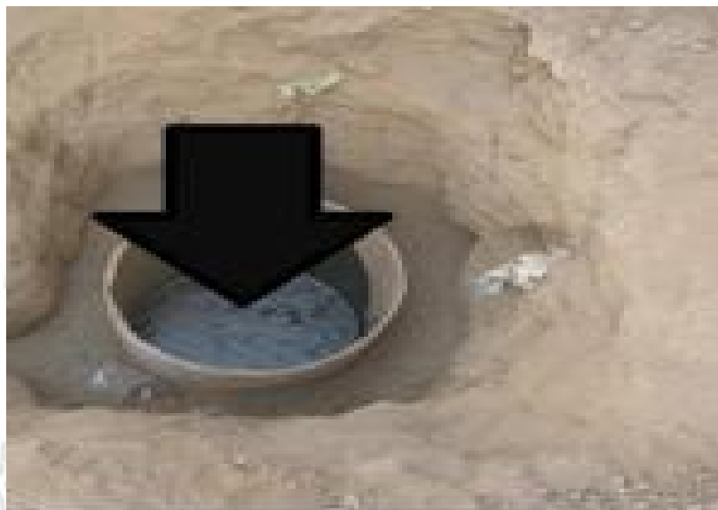
Fig. 4.8 .- Vaciado del aditivo
