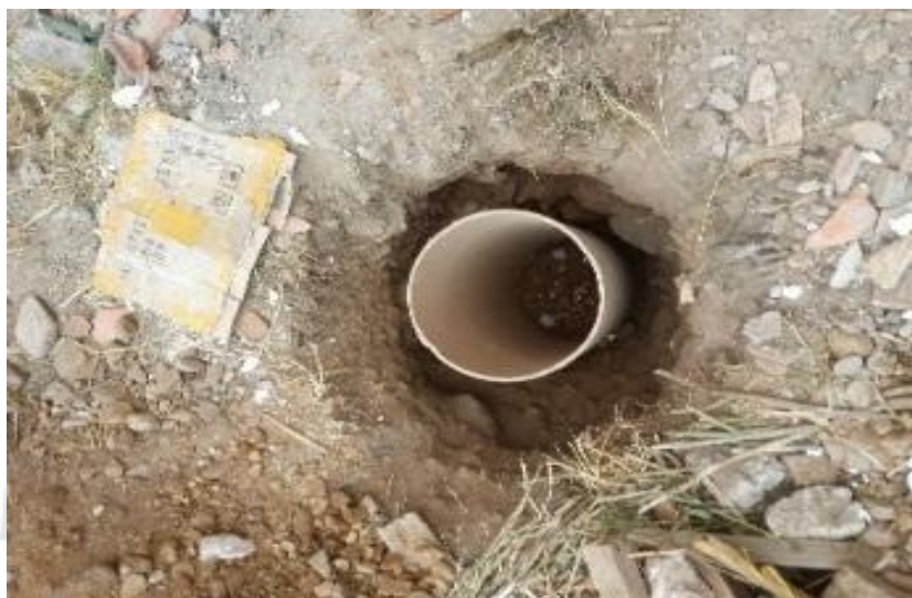
Fig. 4.6 .- Vaciado del material de relleno
