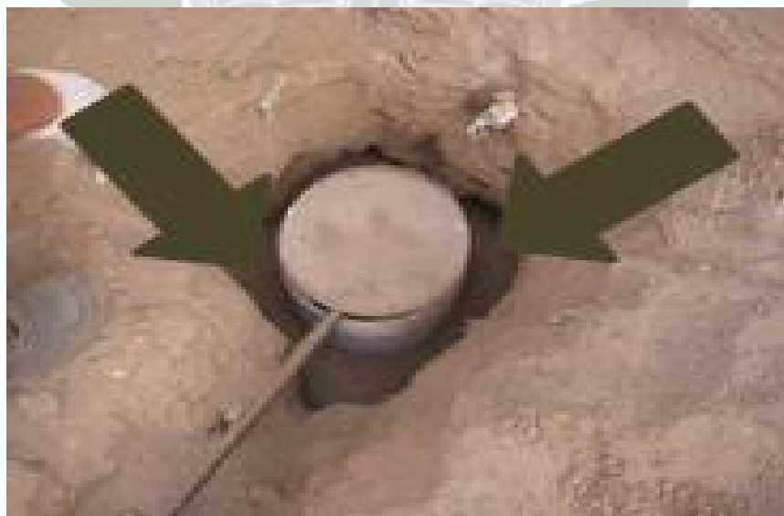
Fig. 4.8 .- Colocación de tierra preparada
