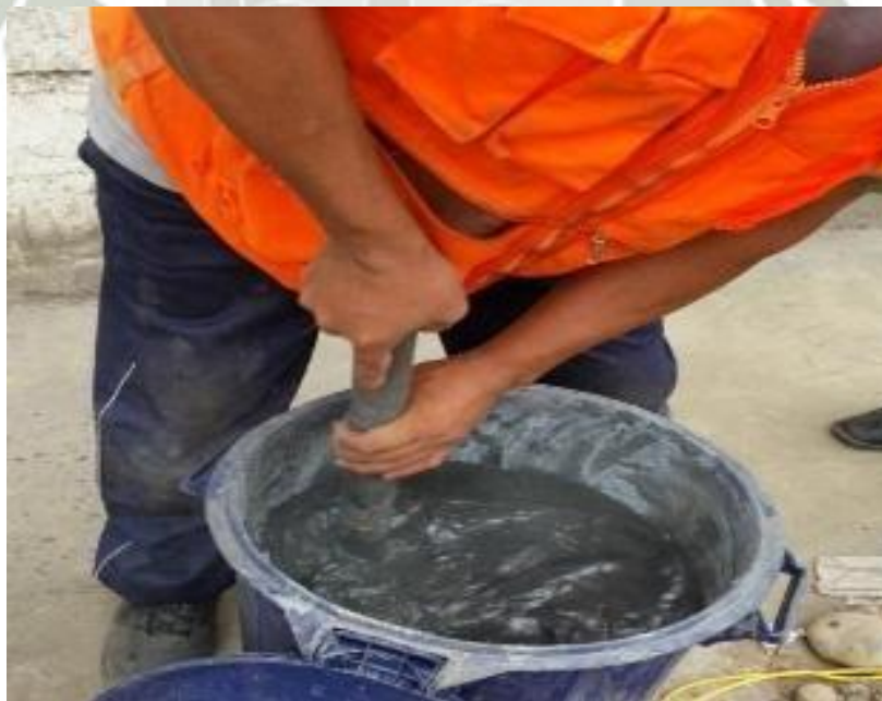
Fig. 4.7 .- Mezcla del aditivo
