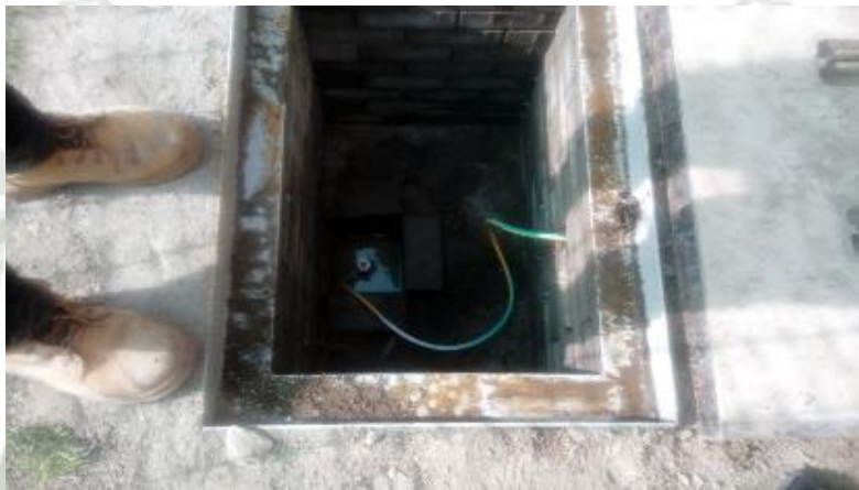
Fig. 3.7.- Foso para el electrodo
