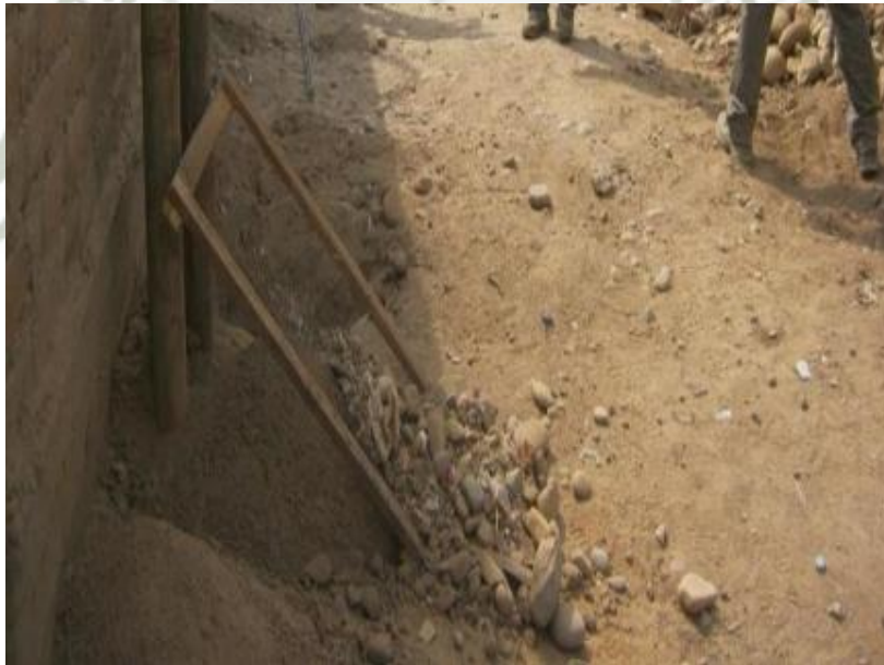
Fig. 4.5 .- Cernido del sistema de puesta a tierra
