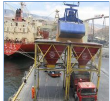
Descarga Tolva a Camión
