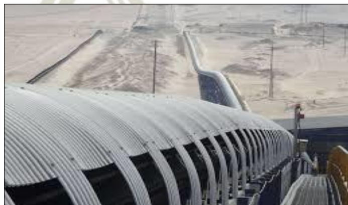
Figura 21 Cobertura en una faja transportadora
