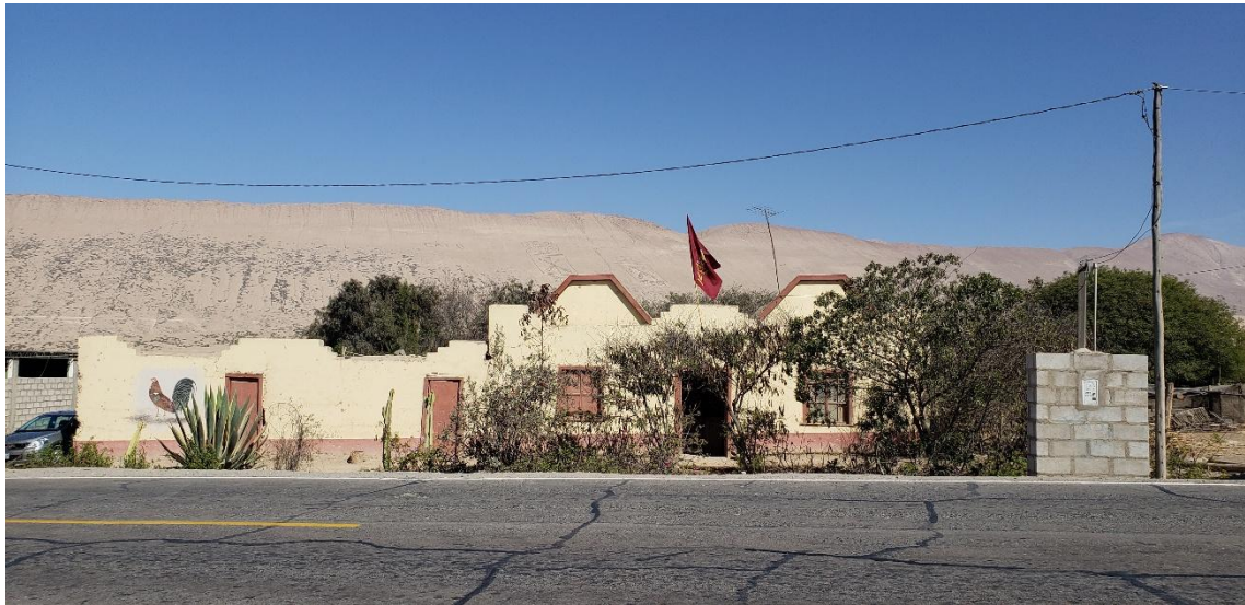
Figura 51. Vista de la fachada principal de vivienda de Doña Margarita Vargas Sánchez
