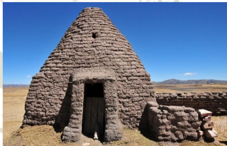
Figura 7. Fachada de putuco tradicional
