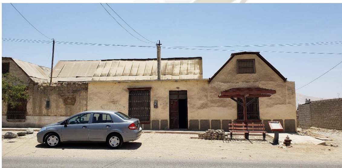
Figura 61. Vista de la Fachada principal de vivienda de Don Deninston Vizcarra Guzmán
