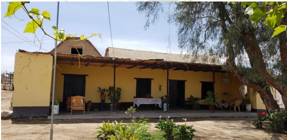
Figura 55. Vista de Fachada principal de vivienda de Doña Bertha Victoria Pizarro Aliaga
