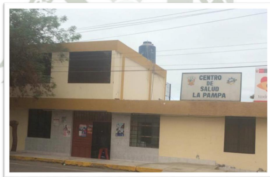
Foto N°6: Centro de Salud La Pampa
