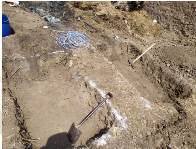
Figura 34. Construcción de Lagunas de estabilización facultativa a escala
