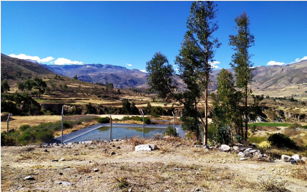
Figura 19. Vista del terreno del terreno propuesto para la PTAR
