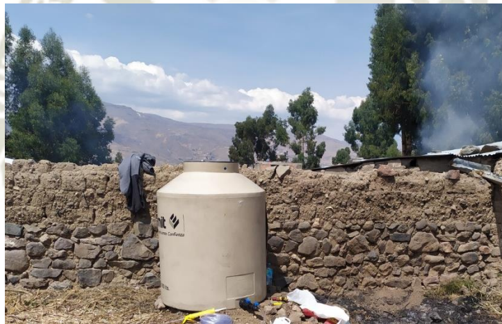
Figura 32. Tanque Rotoplas que actúa como reservorio de agua residual
