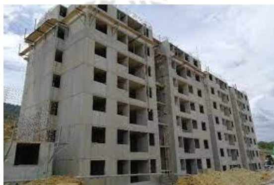
Figura 1: Ejemplo sistema muros estructurales (Silva Omar, 2016)
