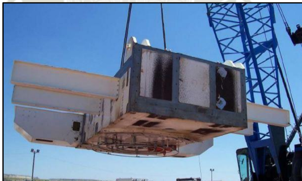
Figura 15 - Estructura giratoria – Revolving frame
