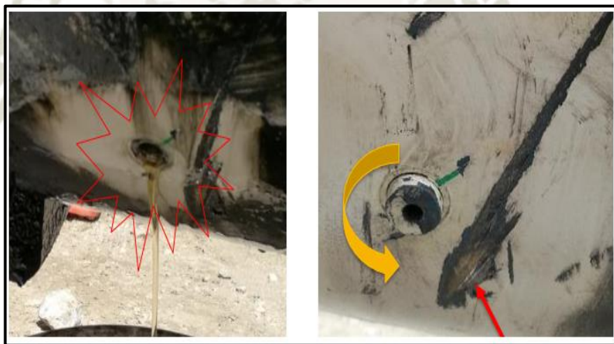
Figura 67 - Tap de purgado lado vástago con fuga – Pala SH001
