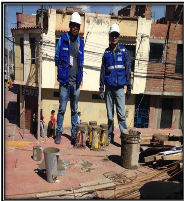
Figura 14. Visita a obra.
