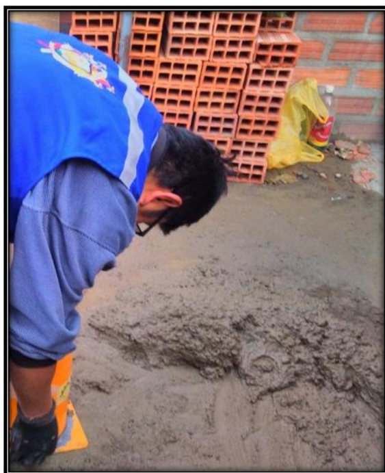
Fig. 159. Concreto preparado sin materias extrañas
