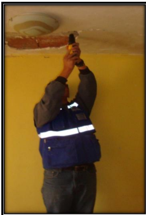
Figura 27. Prueba de esclerómetro en viga.
