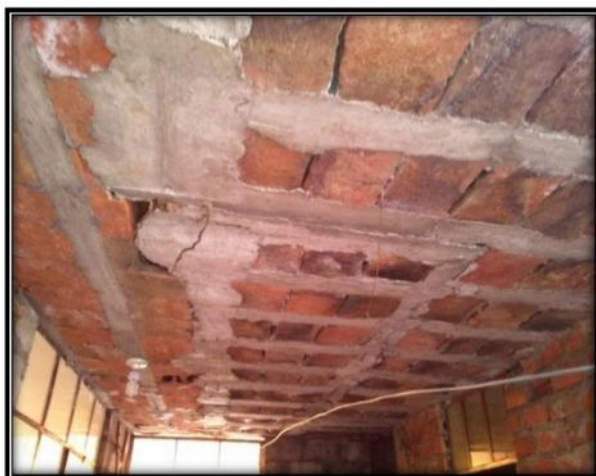
Fig. 171. Viguetas cruzadas en la losa aligerada
