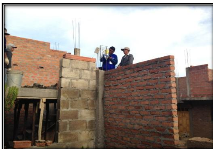
Fig. 185. Vivienda con distintas unidades de albañilería.
