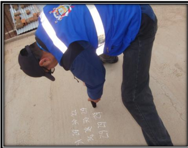
Figura 25. Prueba de esclerómetro en la losa.
