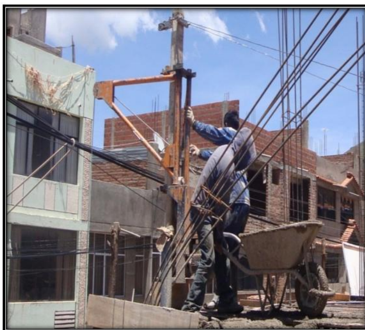
Fig. 148. Colocación de concreto y traqueteo de la carretilla.
