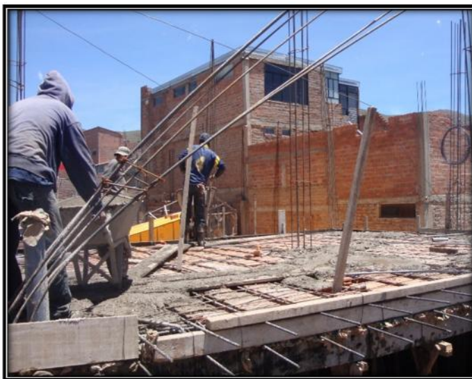
Fig. 150. Descarga del concreto de manera desordenada.
