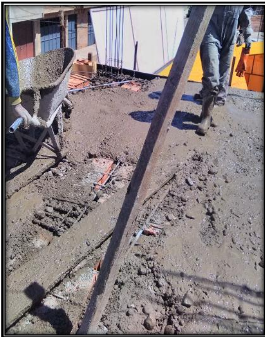
Fig. 123. Concreto de baja trabajabilidad
