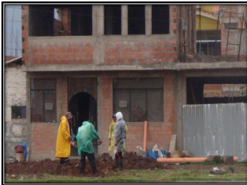
Figura 5. Excavación de zanjas en el terreno.
