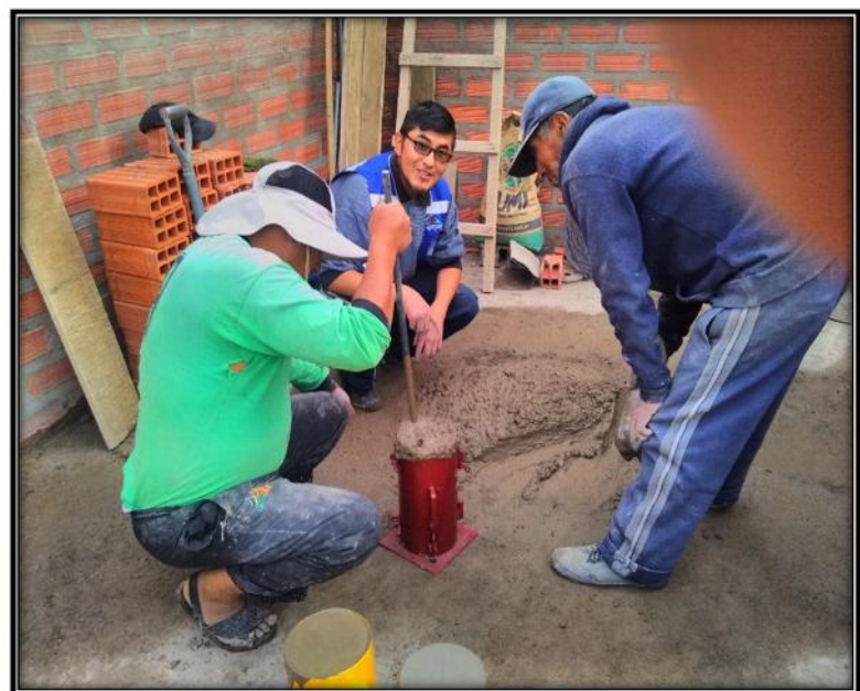
Fig. 119. Toma de muestras o testigos de concreto
