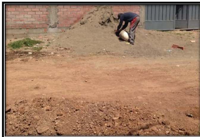
Figura 2. Limpieza de terreno por parte de un trabajador.
