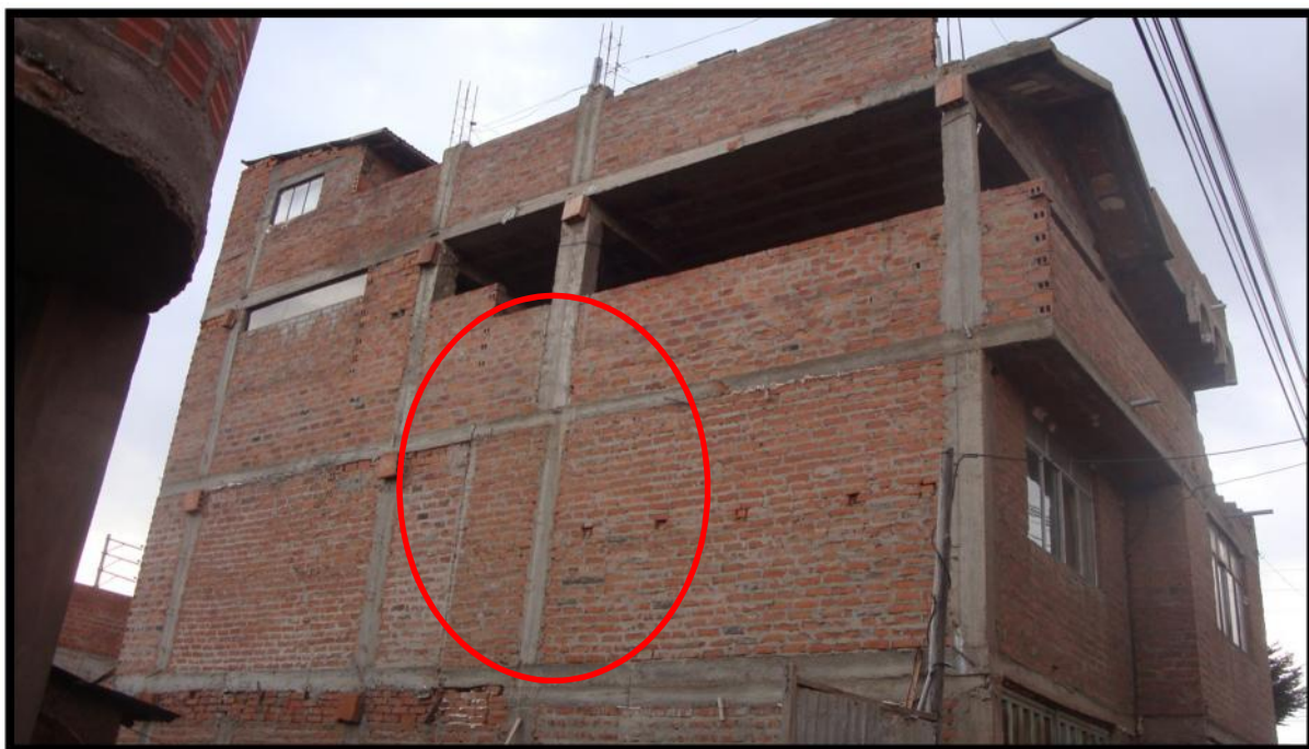
Figura 51. Vivienda que presenta discontinuidad de los elementos estructurales, también observamos dos tipos de ladrillo en el muro.
