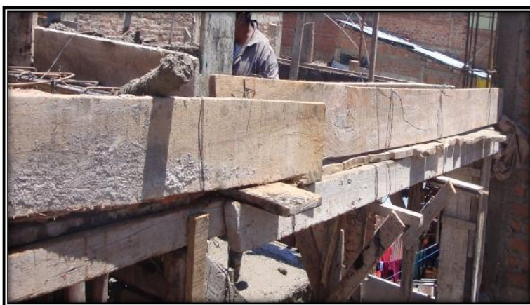
Fig. 204. Tablas trozadas usadas como encofrado
