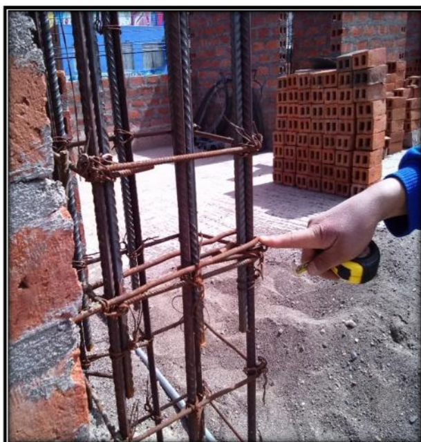
Fig. 98. Refuerzos de aceros y empalmes
