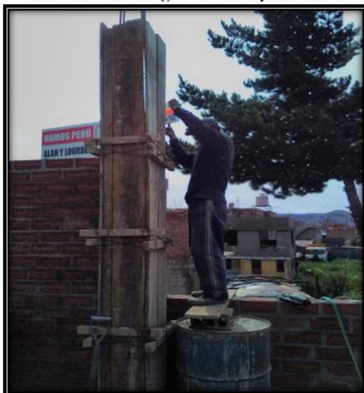
Fig. 198. Trabajo en altura para vaciado de columna
