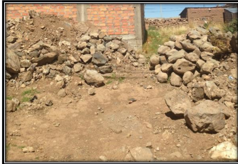
Figura 1. Trabajos preliminares previos a la construcción.
