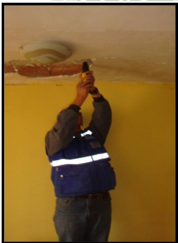
Figura 59. Fisura ubicada en la losa de techo de la vivienda .
