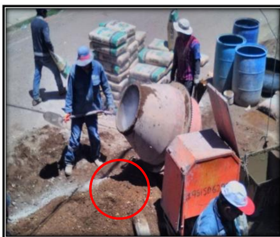
Fig. 70. Presencia de Tierra en el Agregado
