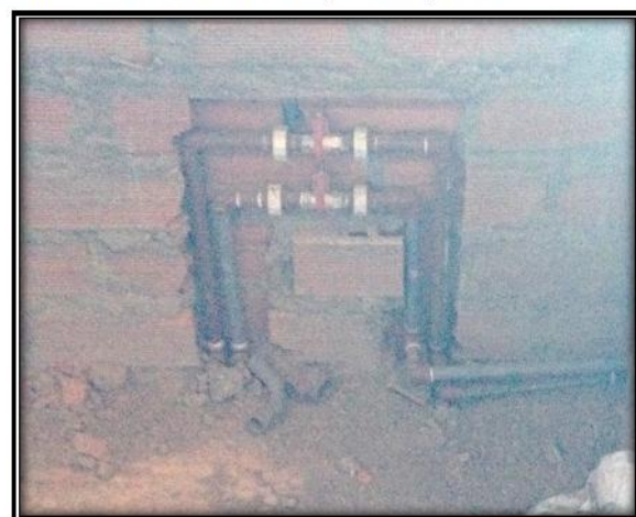
Fig. 175. Picado del muro para instaluciones sanitarias
