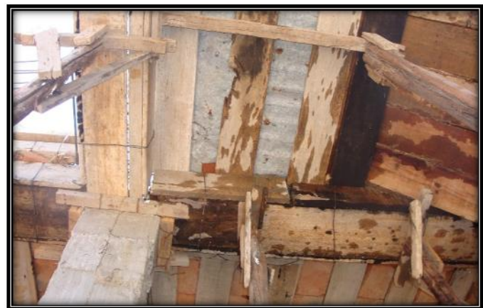
Fig. 208. Calamina usada a modo de encofrado
