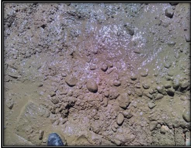
Fig. 122. Concreto en losa aligerada
