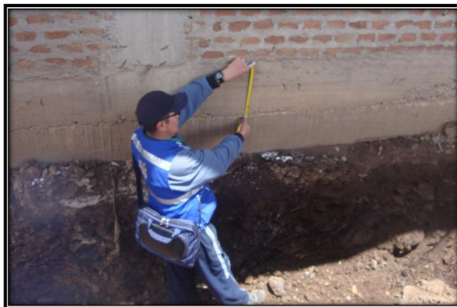
Figura 6. Excavación de zanjas para la edificación
