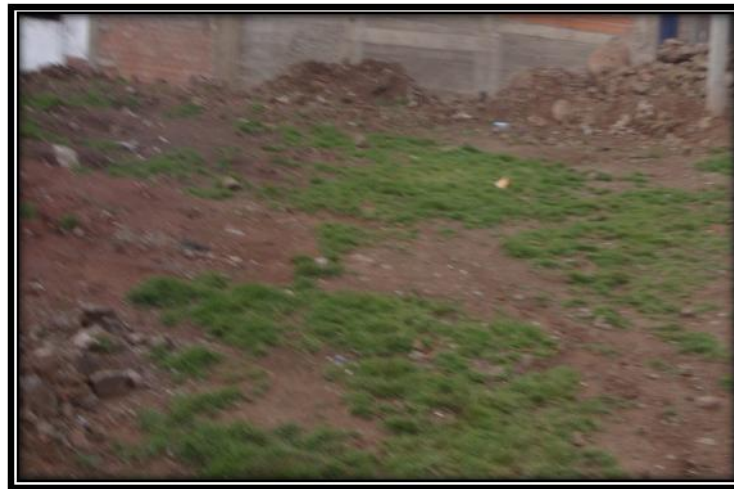
Figura 4. Movimiento de tierras en el terreno.
