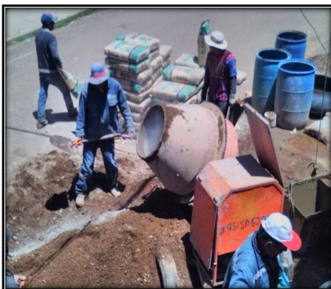
Fig. 126. Preparación de Concreto para losa
