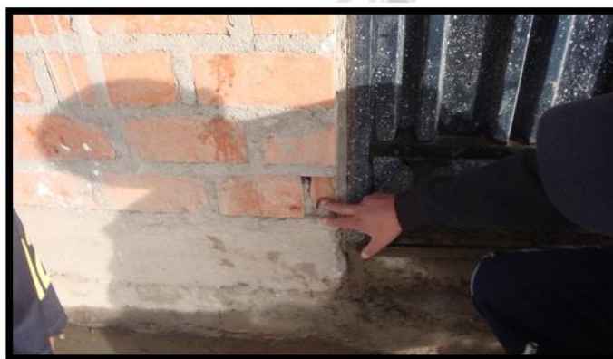
Figura 38. Calidad del mortero fácil desmoronamiento al raspado
