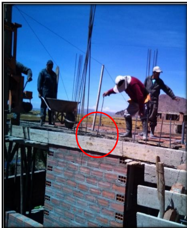
Fig. 145. Varillado o “Chuseo” en una losa aligerada
