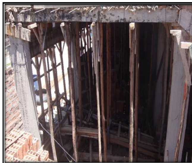
Fig. 205. Puntos mal alineados y excesivo espaciado
