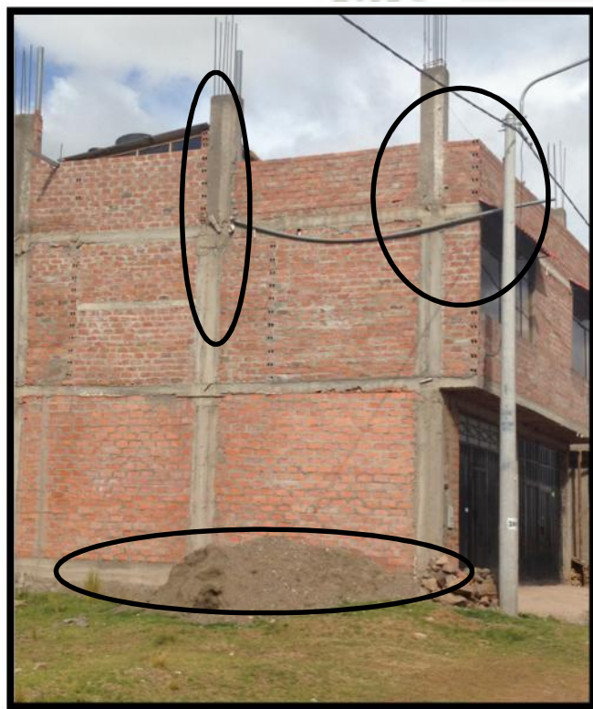
Figura 50. Vivienda que presenta problemas constructivos: a) Se observa arena al lado de la vivienda (debilita la estructura). b) Discontinuidad en los elementos estructurales. c) Acero descubierto que sobresale en el último piso.
