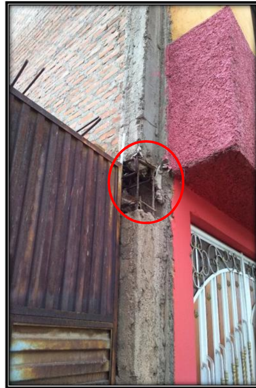
Fig. 77. Ganchos conexión viga-columna
