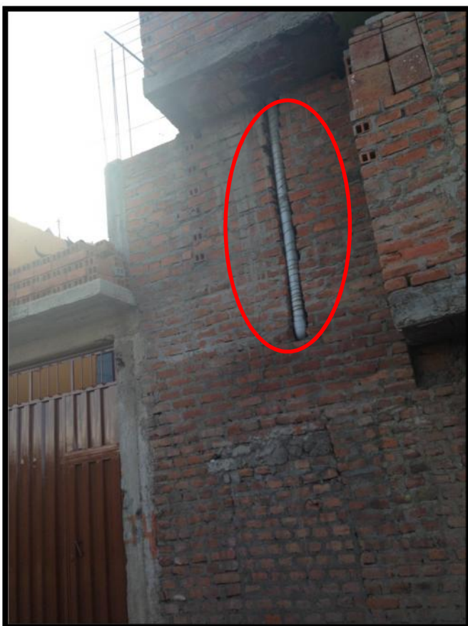
Figura 52. Vivienda que presenta discontinuidad en los elementos estructurales.
