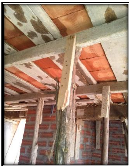
Fig. 113. Puntal deteriorado
