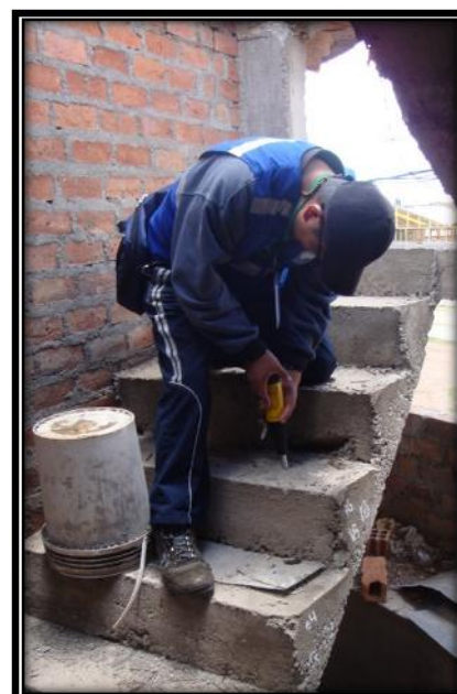
Figura 28. Prueba de esclerómetro en escalera.
