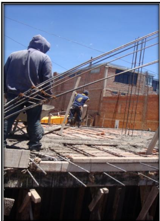
Fig. 134. Vaciado de la losa aligerada
