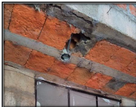
Fig. 170. Octogonales en medio de las viguetas
