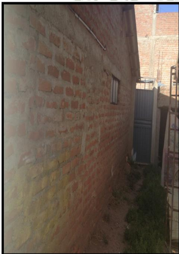
Figura 65. Vivienda modular que no tiene elemento de cimentación.
