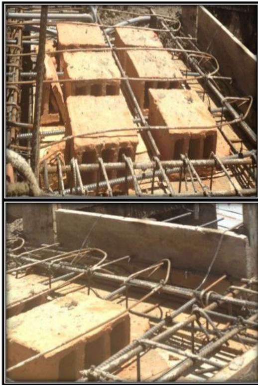
Fig. 173. Viguetas de la losa aligerda
