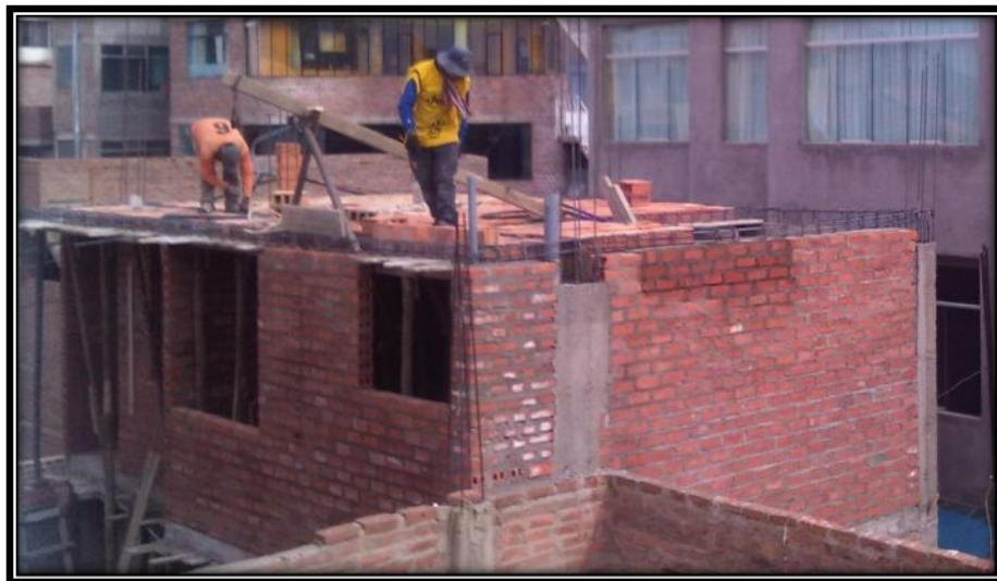
Figura 8. Proceso constructivo de una losa aligerada.
