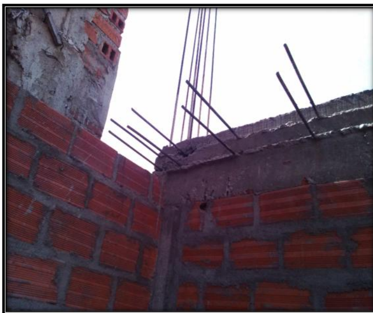
Fig. 157. Planos de vaciado en la losa aligerada
