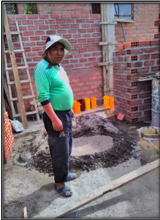
Fig. 118. Preparación del concreto
