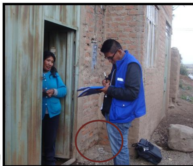
Figura 49. Vivienda que no presenta altura de sobrecimiento, por tal motivo se observa ladrillos dañados por la humedad
