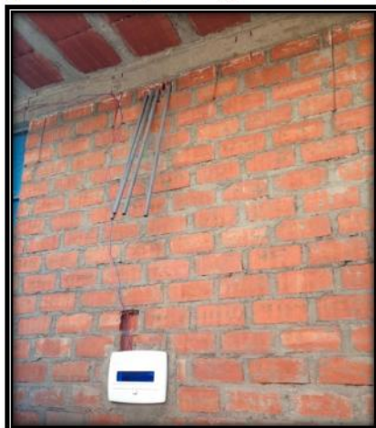
Fig. 174. Se pican los muros para colocar accesorios.
