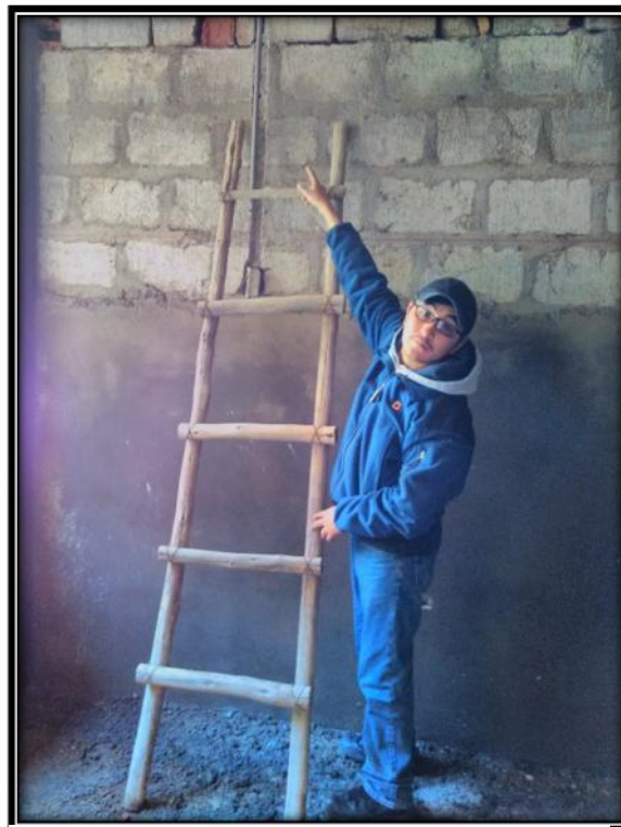
Figura 9. Acabado de muro con uso de bloquetas.
