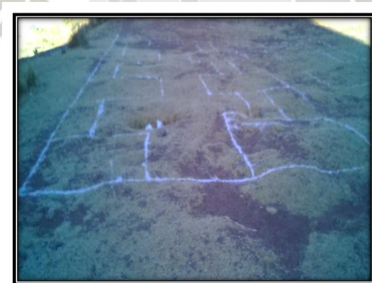
Figura 3. Replanteo de ejes para una edificación.
