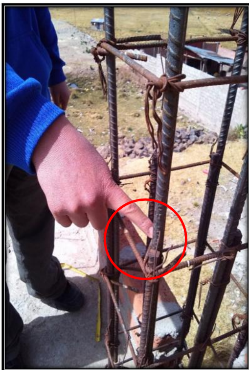
Fig. 92. Estribos en mal estado para la construcción
