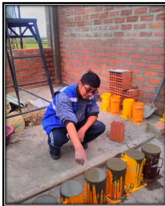
Figura 15. Testigos de concreto en otra visita a obra.
