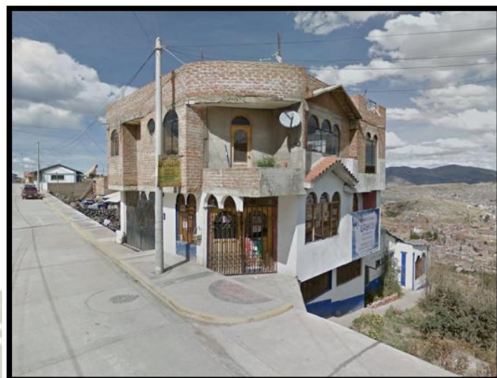
Figura 55. Vivienda de forma irregular en elevación
