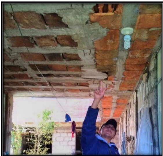
Fig. 169. Viguetas interrumpidas en su paso
