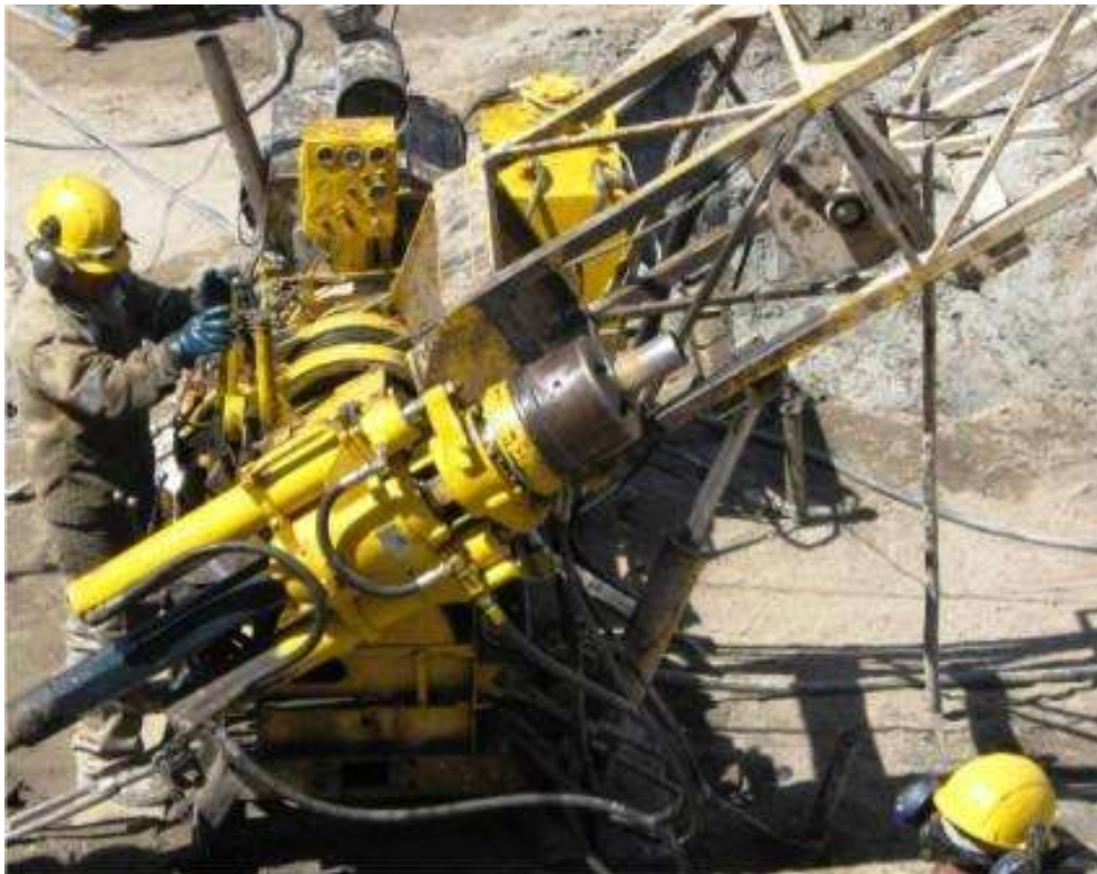
Figura N°3.2 Equipo De Perforación Diamantina
