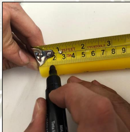
Figura 07: Marcado de Tuberías.
