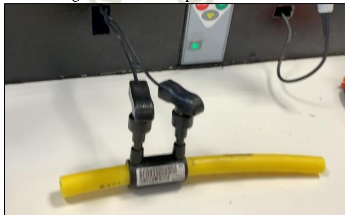
Figura 05: Soldado por Electrofusión
