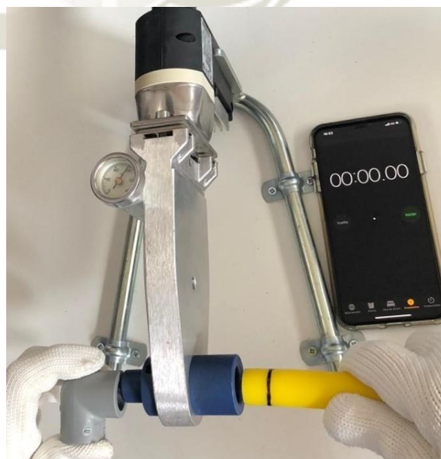
Figura 09: Calentamiento de Tuberías
