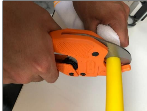
Figura 06: Corte de Tubería.
