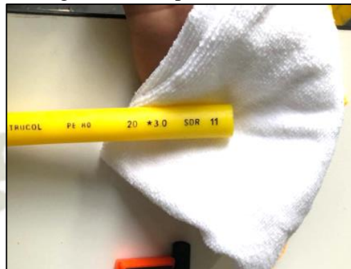
Figura 02: Limpieza de Tubería
