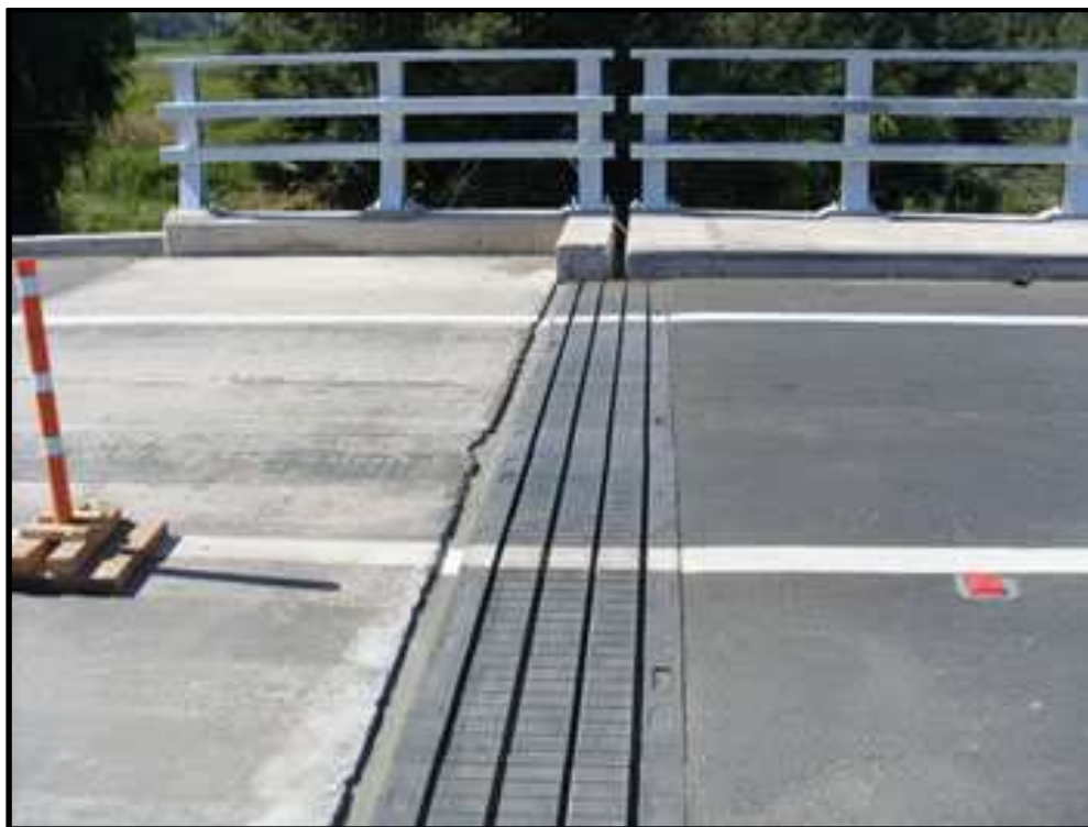
Figura 57 – Junta de Dilatación Estribo con Puente Añashuayco, (Fuente: www.composanpuentes.com )
