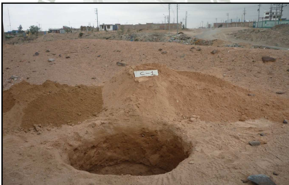
Figura 18 –Vista de Calicata C-1 en la Zona del Proyecto (Elaboración Propia)
