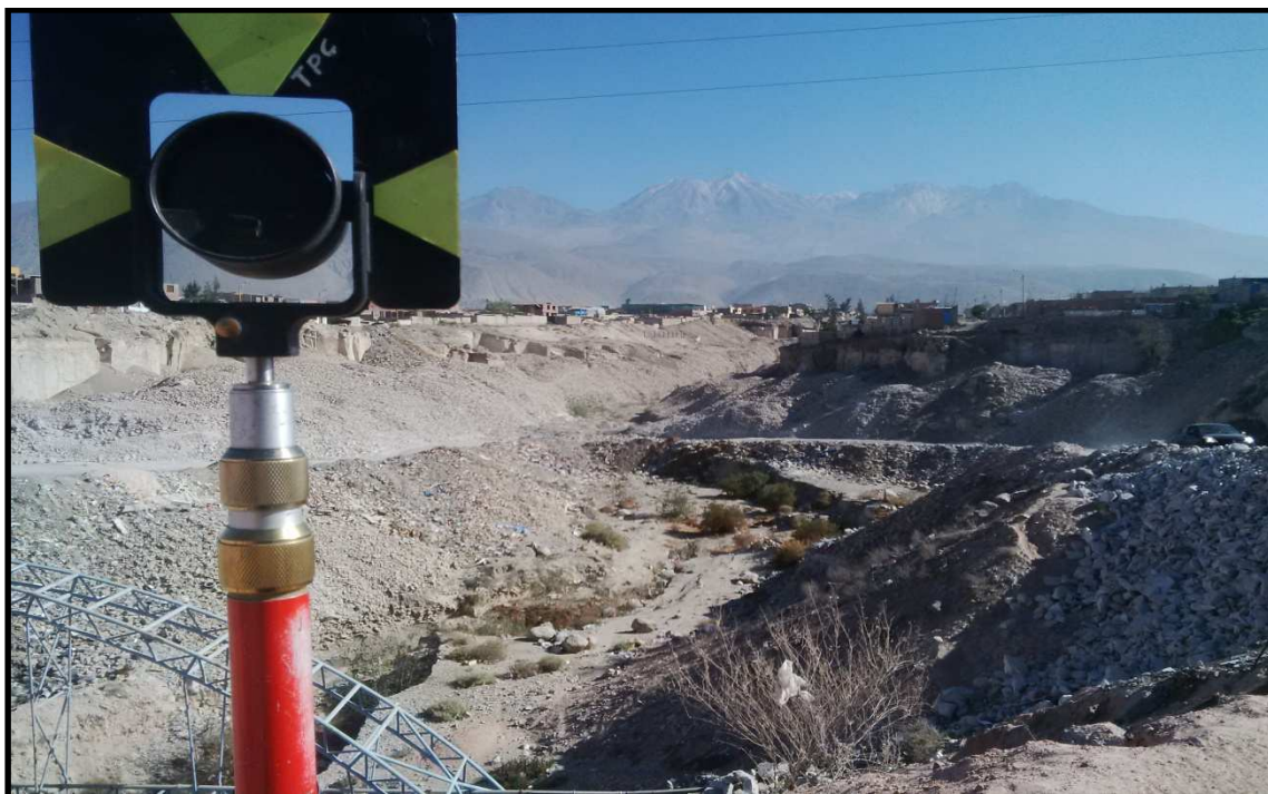
Figura 6 - Levantamiento Topográfico con Prisma Topográfico (Vista Propia)
