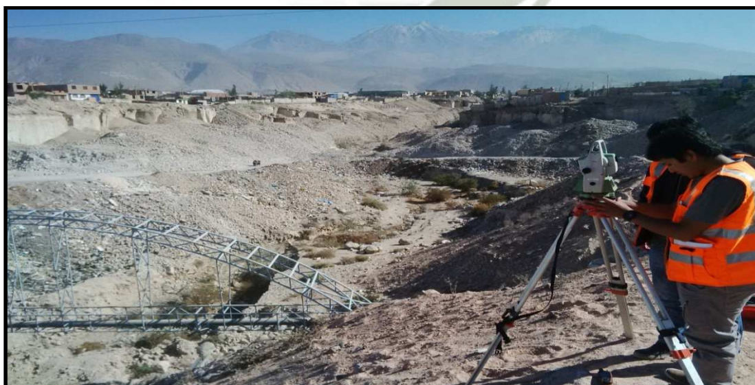
Figura 5 - Levantamiento Topográfico con Estación Total (Vista Propia)
