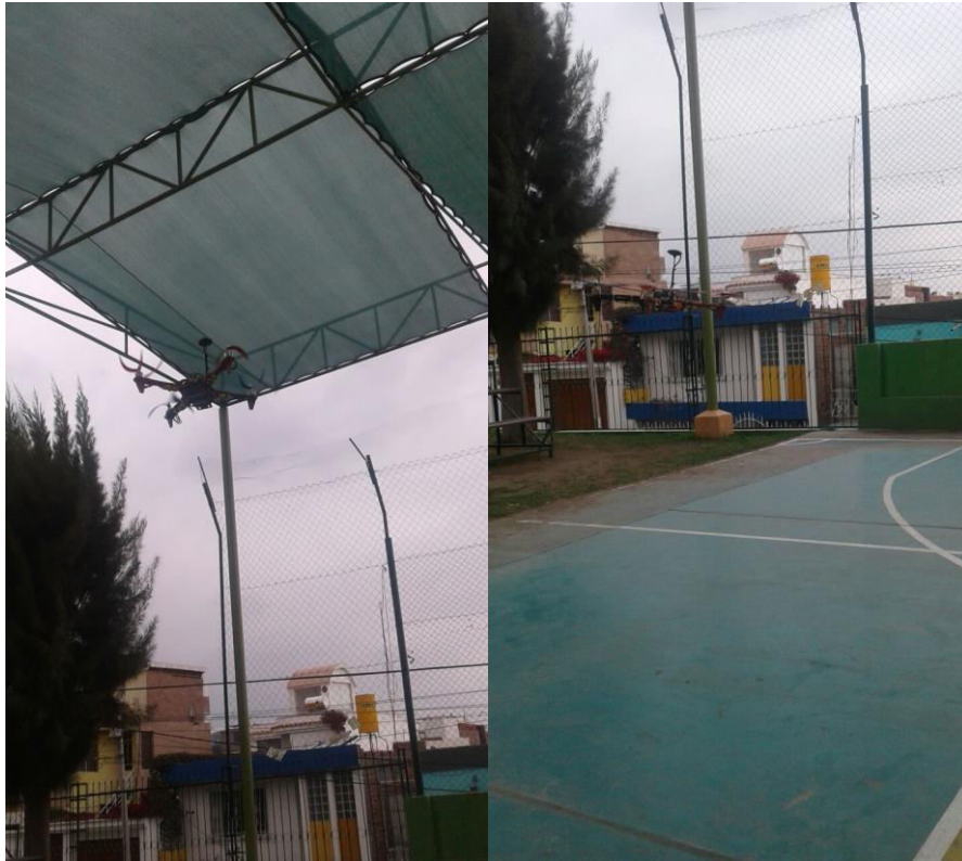
Figura6.9: Estabilización del equipo
