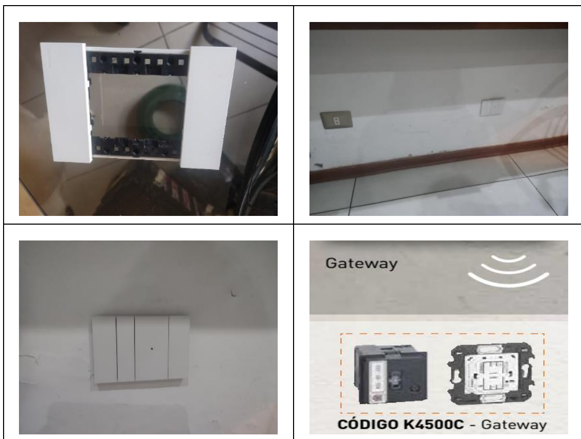
Figura 37: Imágenes de la instalación del GATEWAY en la vivienda unifamiliar
