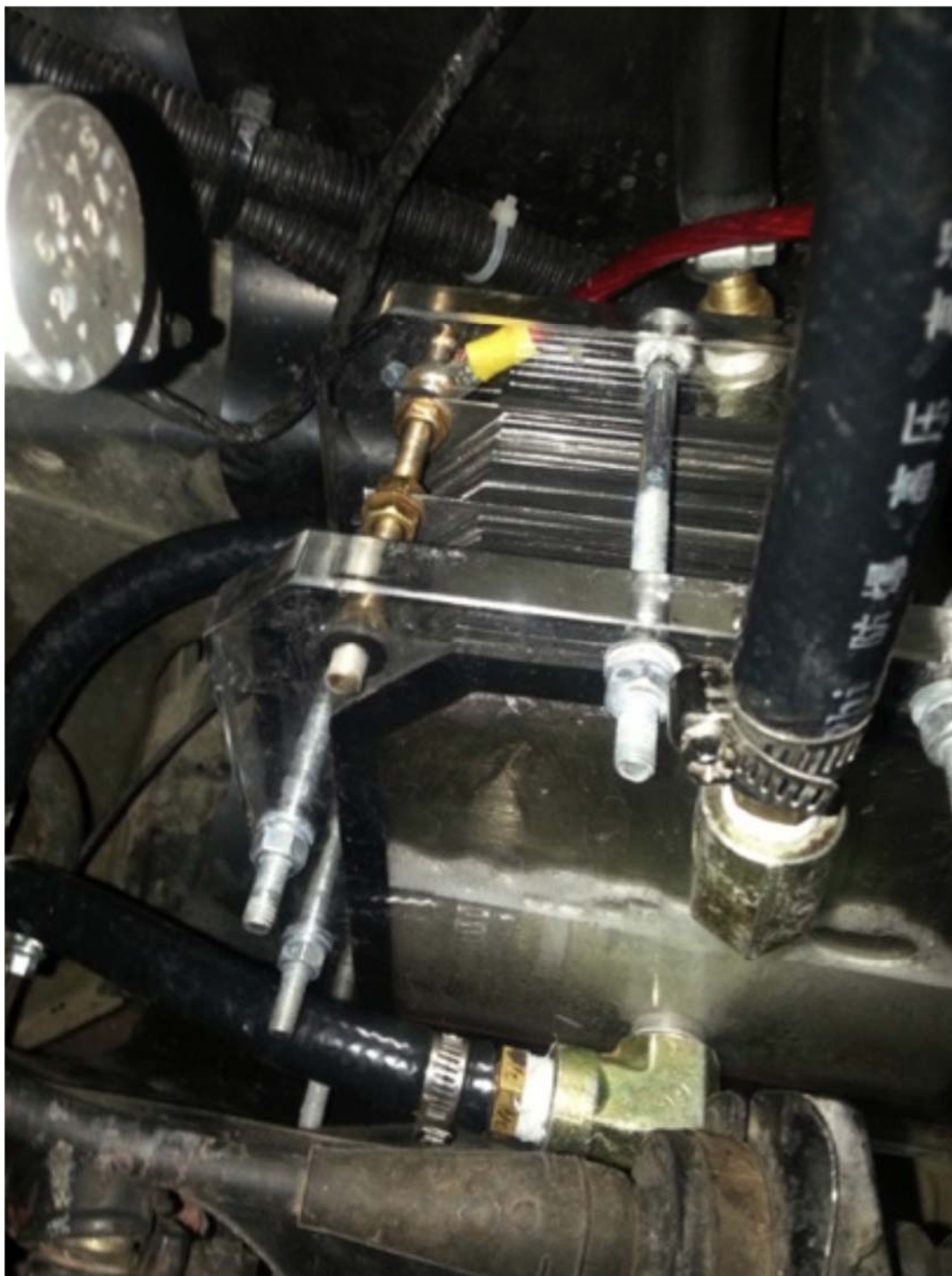
GRÁFICA 3.32. Generador en funcionamiento
