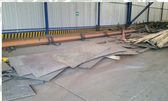
Foto N° 65: Almacenamiento de Material
