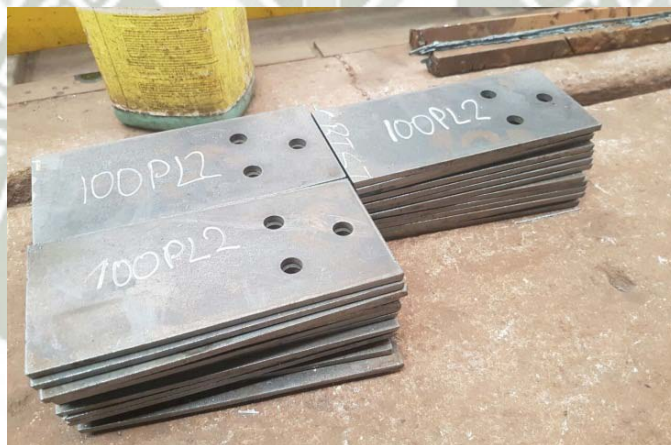
Foto N° 43: Codificación de Piezas Habilitadas
