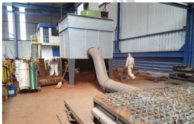
Foto N° 57: Limpieza de GEMINI por falta de Mantenimiento
