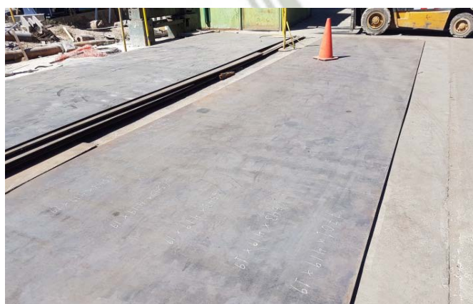
Foto N° 41: Trazo de Planchas
