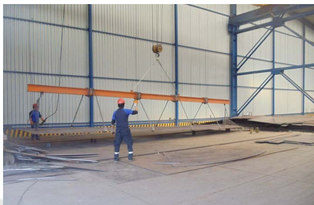
Foto N° 61: Puente Grúa Ocupado
