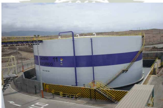
Foto N° 2: Fabricación y Montaje de Tanques
