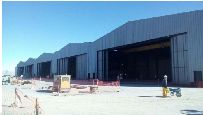
Foto N° 3: Fabricación y Montaje de Hangares FAP
