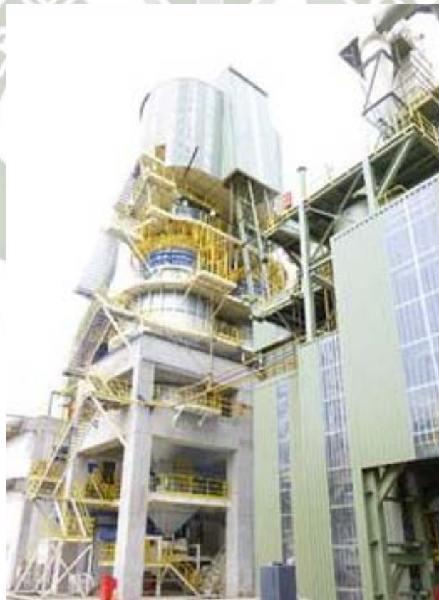
Foto N° 4: Fabricación y Montaje de Horno Maerz–Calquipa
