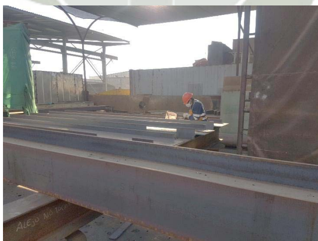
Foto N° 21: Habilitado Manual con Esmeril de Corte
