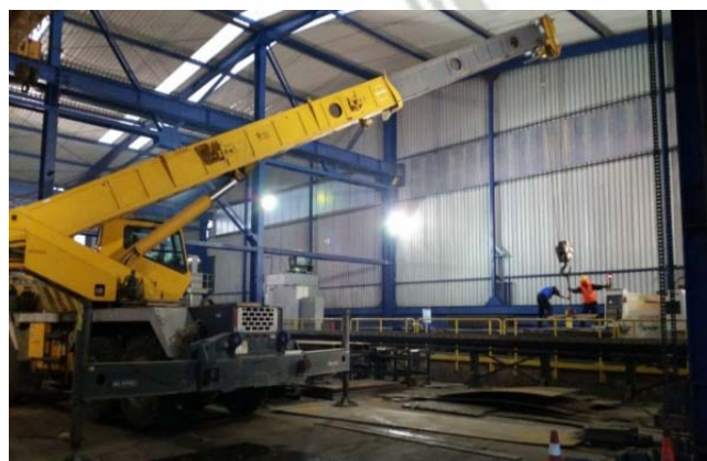
Foto N° 60: Puente Grúa Inoperativo
