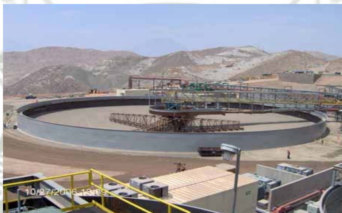
Foto N° 1: Fabricación y Montaje de Espesadores
