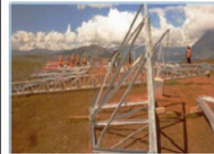
Montaje de la Torre T 220
