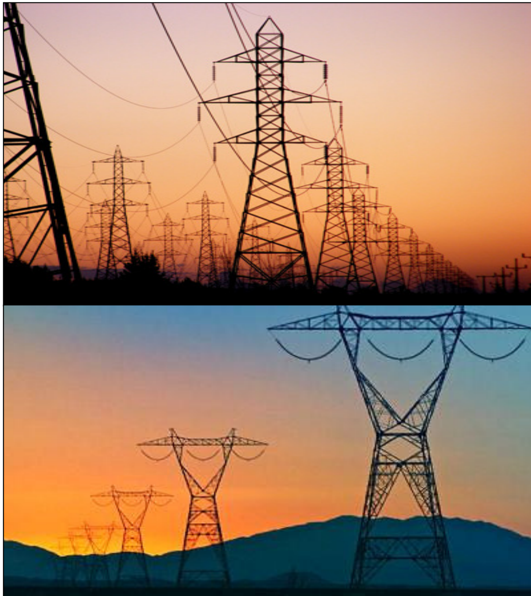
Fotografía 2.4. Líneas de Transmisión. Copyright 2011 Abengoa
