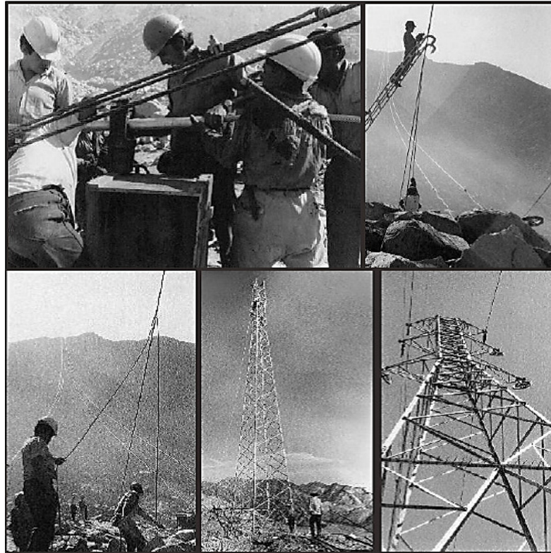
Figura 2.3. Trabajos constructivos LT Barbablanca. Copyright 2007 MINEM
