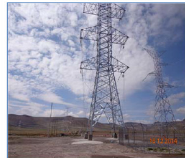
Torre N° 01 LT, 220 kV Cotaruse-Las Bambas
