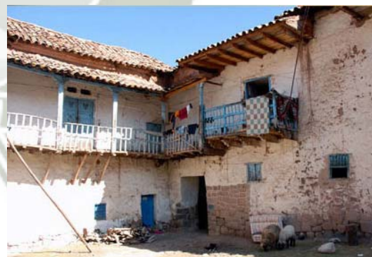
Imagen No. 2. 8 – Casa Cartagena antes de la intervención.
