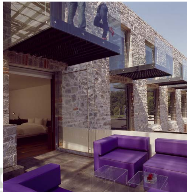
Imagen No. 2. 6 – Balcones de vidrio en fachada de piedra.
