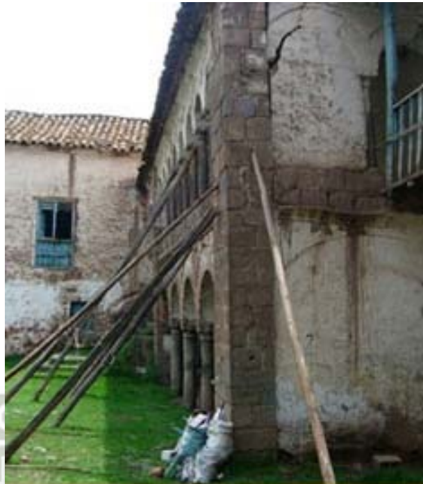
Imagen No. 2. 9 – Casa Cartagena antes de la intervención.
