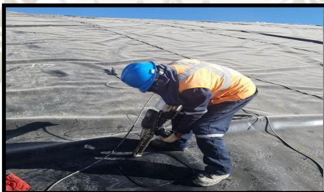
Figura 40: Reparación de geomembrana HDPE E=2.00mm Pad de Lixiviación
