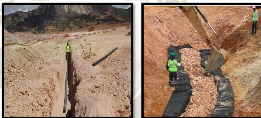
Figura 32: Instalación de tubería subdrenaje y colocación de agregado en Pad de Lixiviación
