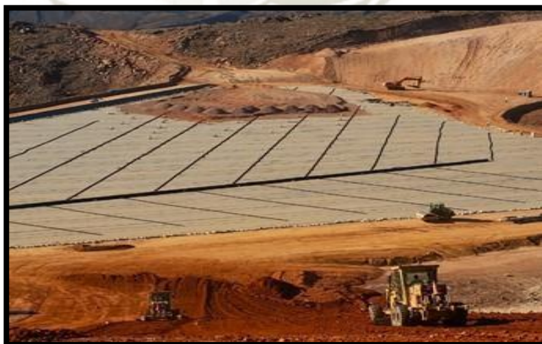
Figura 36: Instalación de tuberías de colección en el Pad de Lixiviación
