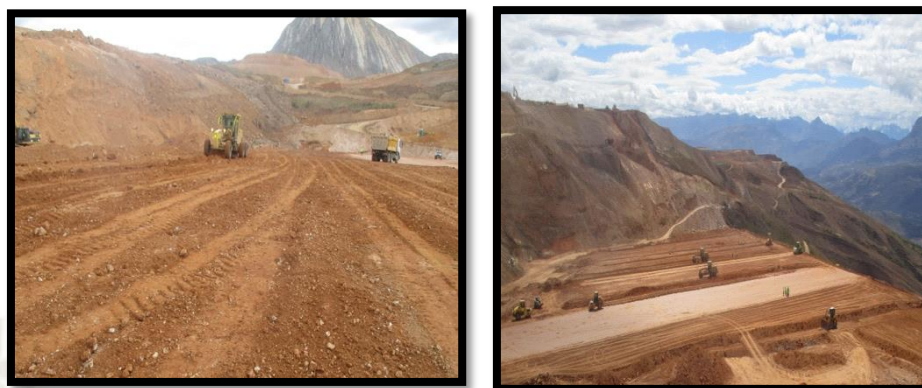
Figura 30: Conformación de relleno estructural en Pad de Lixiviación
