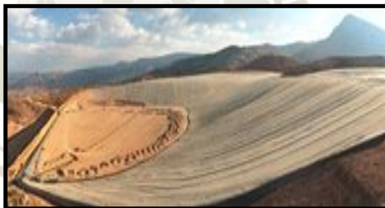
Figura 17: Pad de Lixiviación construido
