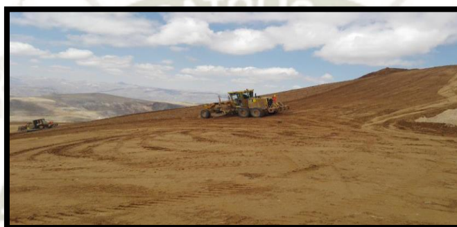
Figura 43: Nivelación de Pad de Lixiviación
