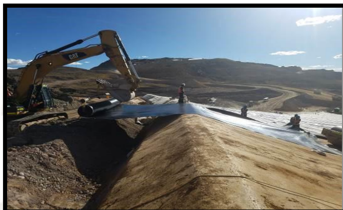
Figura 39: Instalación de geomembrana HDPE E=2.00mm Pad de Lixiviación
