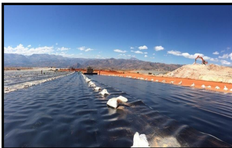
Figura 35: Colocación de geomembrana en Pad de Lixiviación
