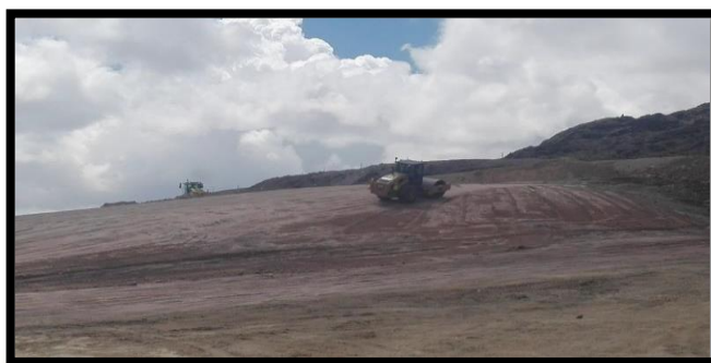
Figura 42: Compactación de Pad de Lixiviación
