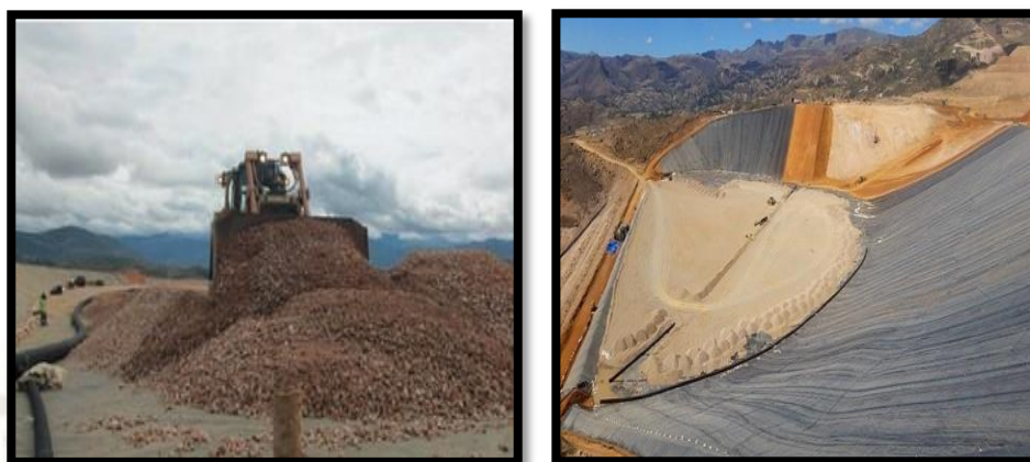
Figura 37: Conformación de overliner en el Pad de Lixiviación
