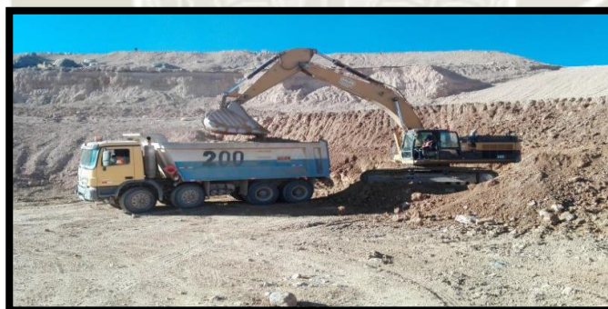
Figura 44: Extracción, carguío y transporte de clay
