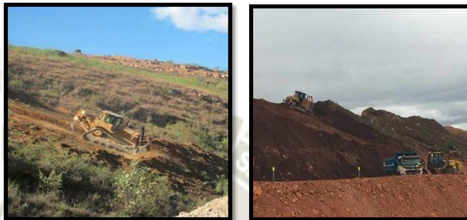
Figura 26: Desbroce de topsoil en Pad de Lixiviación
