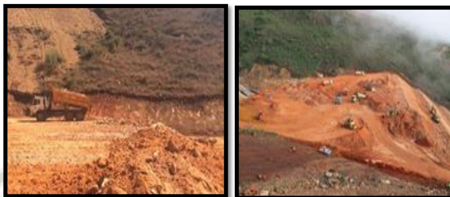
Figura 22: Relleno del Pad de lixiviación
