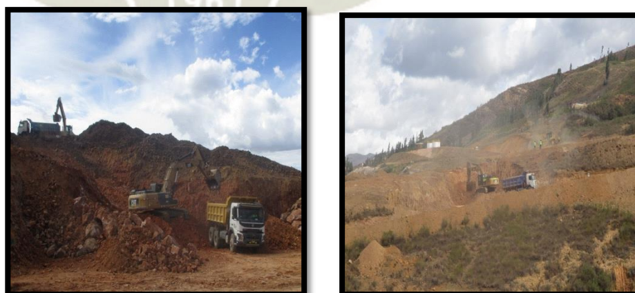
Figura 23: Cantera de relleno estructural y filtro
