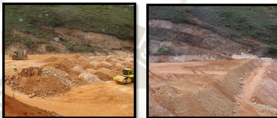
Figura 29: Relleno masivo en capas de 2 m. en Pad de Lixiviación
