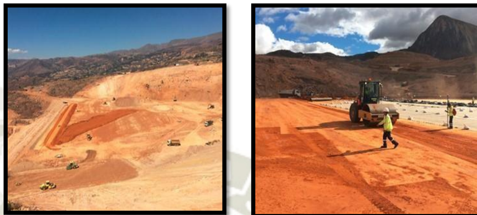
Figura 33: Colocación de soil Liner en Pad de Lixiviación
