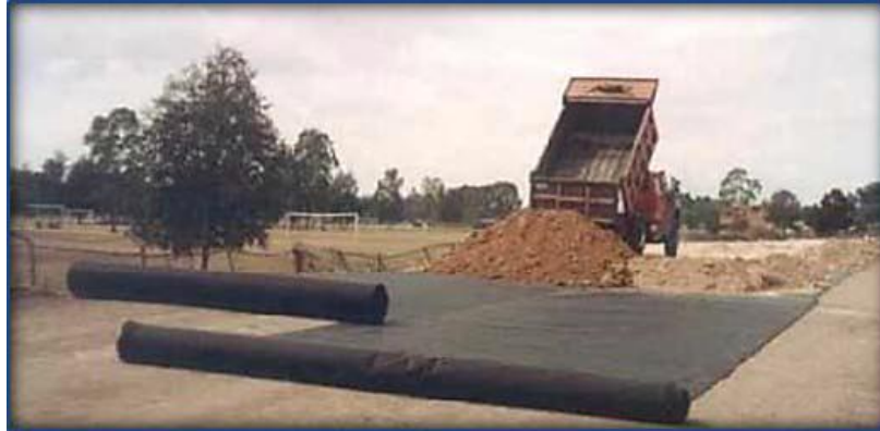
Figura 1.9: Geotextil no tejido usado en separación de caminos.
