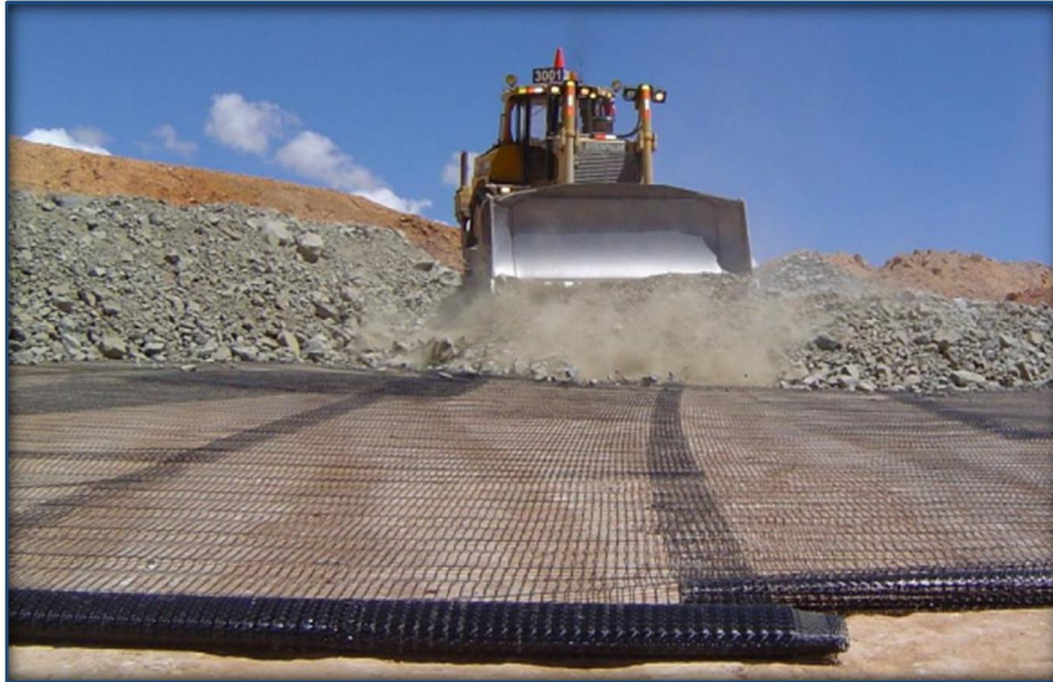
Figura 1.15: Colocación de material de relleno y aseguramiento de los traslapes de la geomalla BX1200.
