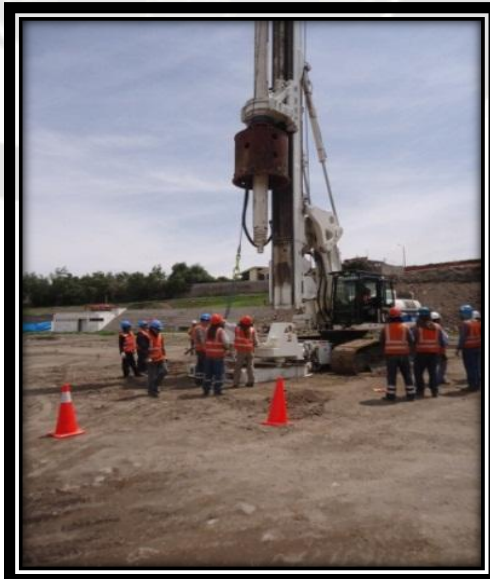
Figura A-1, posicionamiento de la perforadora.
