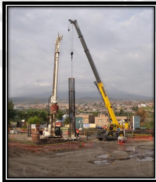
Figura A-5, Izaje de la armadura para el pilote perforado.
