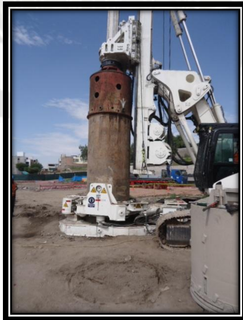
Figura A-4, Colocación de camisa.
