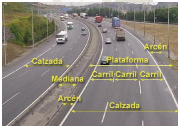
Ilustración 13: Partes de una carretera
