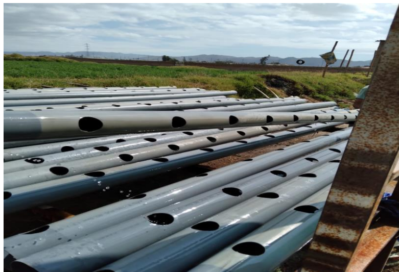
Fotografía 1 Lavado y desinfección de tuberías
