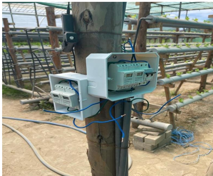
Fotografía 7 Instalación del sistema eléctrico
