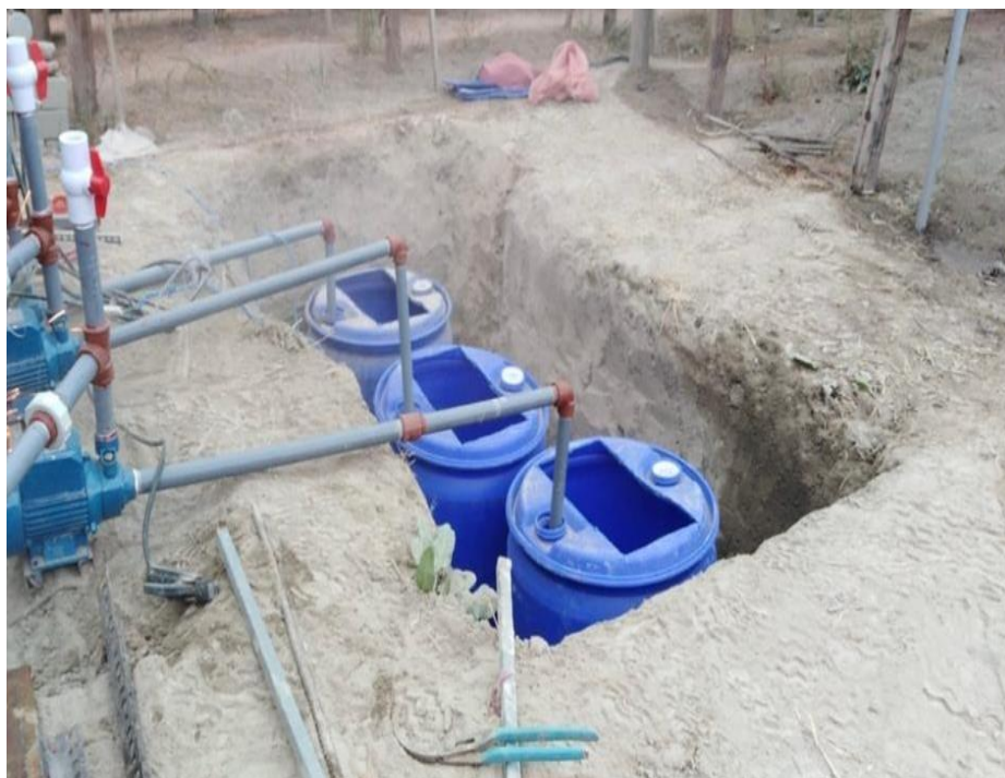
Instalación de bombas periféricas y cilindros de 200L
