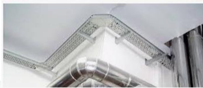
Figura 31 Bandeja Portacable
