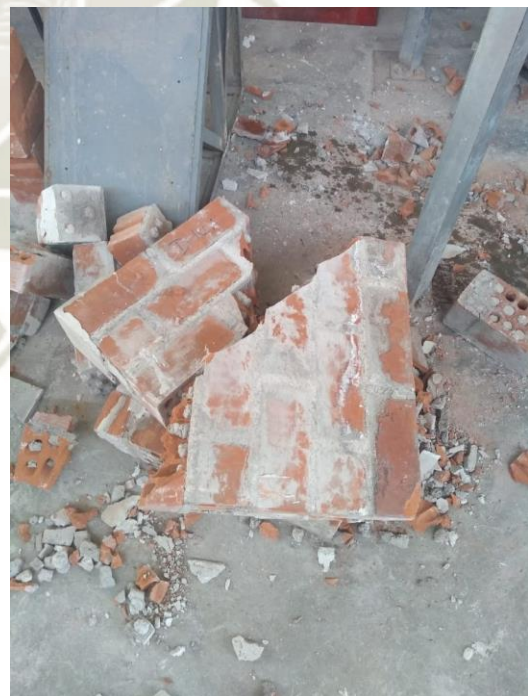
Fotografía 7: Falla por compresión diagonal en muretes de ladrillos mecanizados (Mortero con Diatomita)
