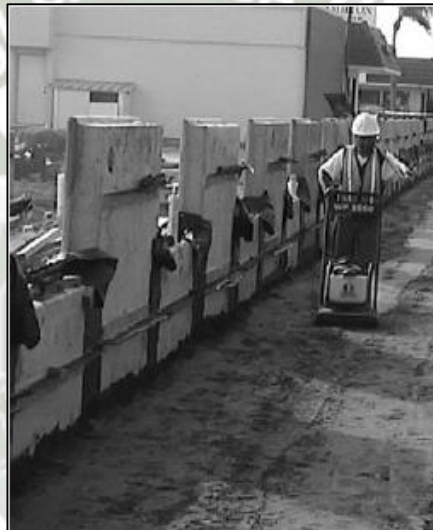
Figura 3-8. – Geotextil no Tejido en la parte posterior de las placas (FHWA-NHI-10-024, 2009)
