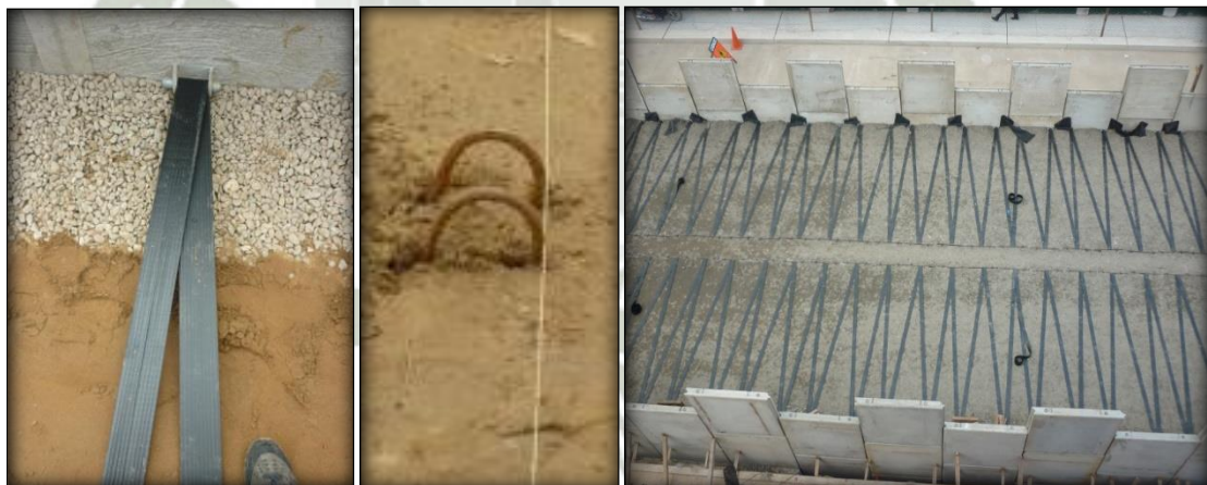
Figura 3-1. – Sistema de Suelo Reforzado de Paneles Segmentados
