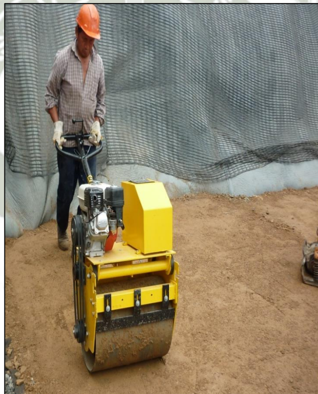
Figura 6-73. – Compactación del relleno estructural con equipo liviano
