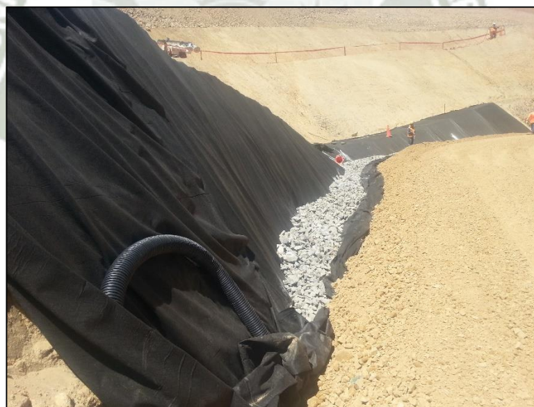
Figura 6-63. – Drenaje en el trasdós del muro mediante piedra chancada envuelta en geotextil no tejido
