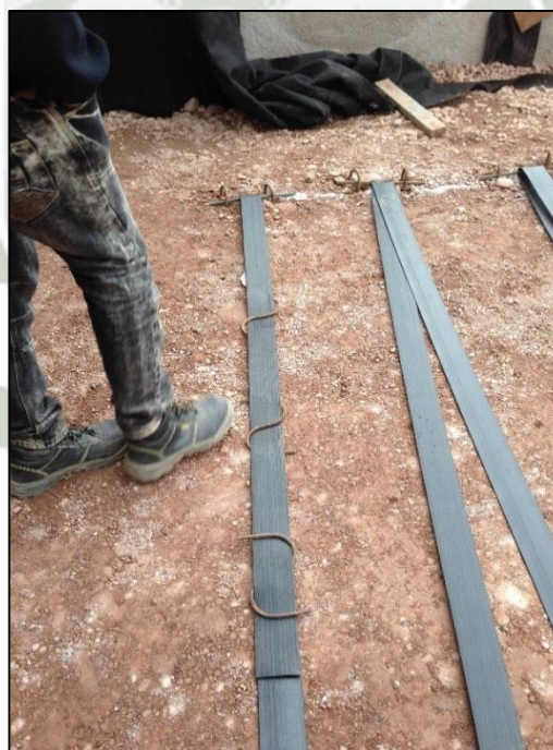
Figura 6-77. – Empalme inicial de la cinta polimérica
