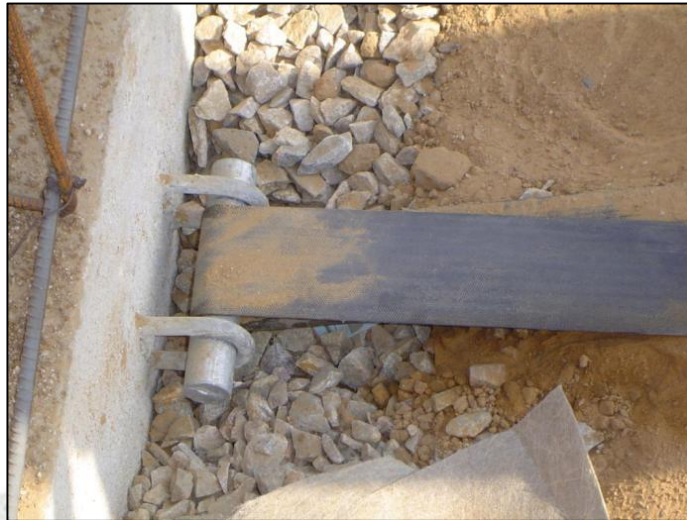
Figura 4-7. – Clavija de Acero Galvanizado
