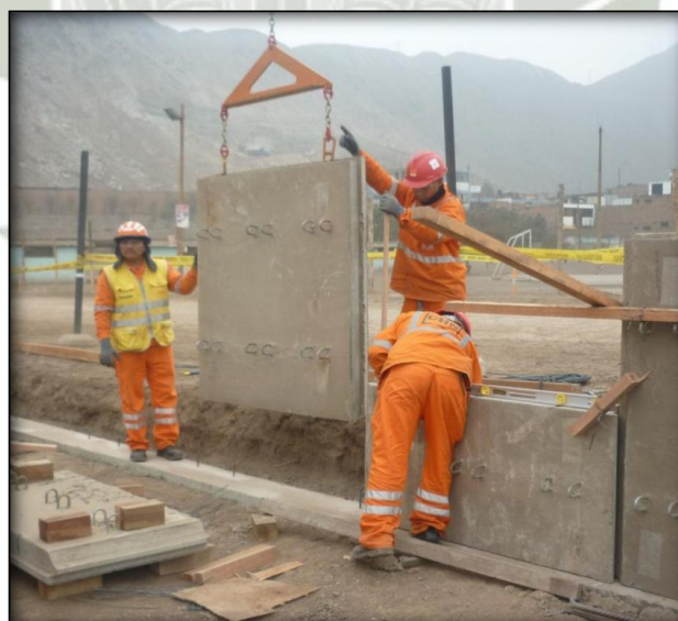
Figura 6-5. – Colocación del panel de concreto prefabricado
