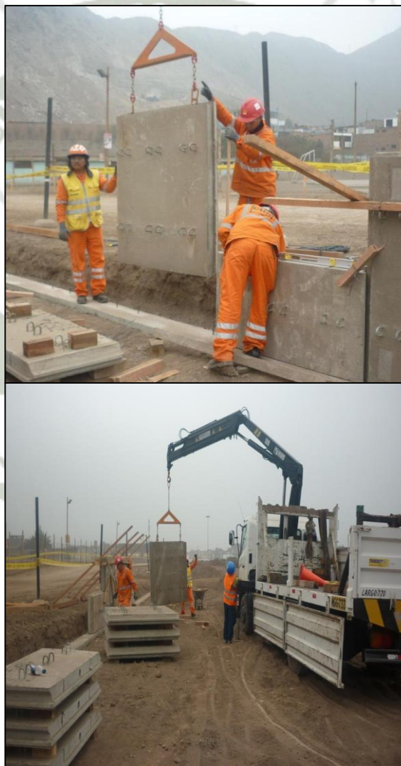
Figura 6-68. – Izaje del panel prefabricado
