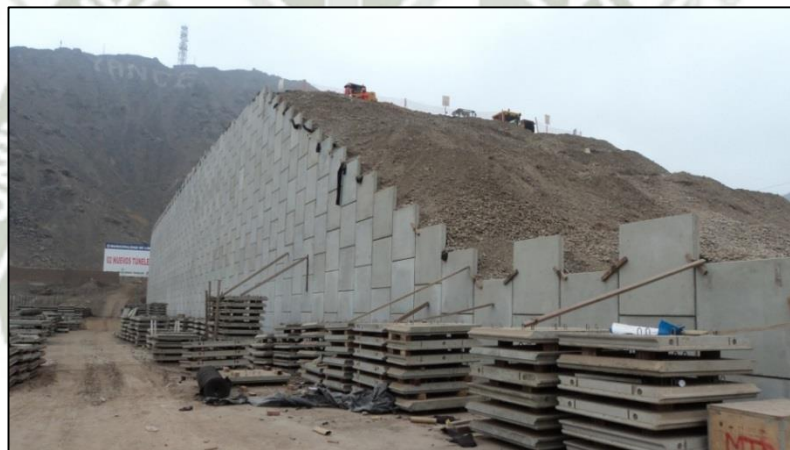
Figura 1-2.- Rampa de Acceso al Túnel Santa Rosa Lima - Perú
