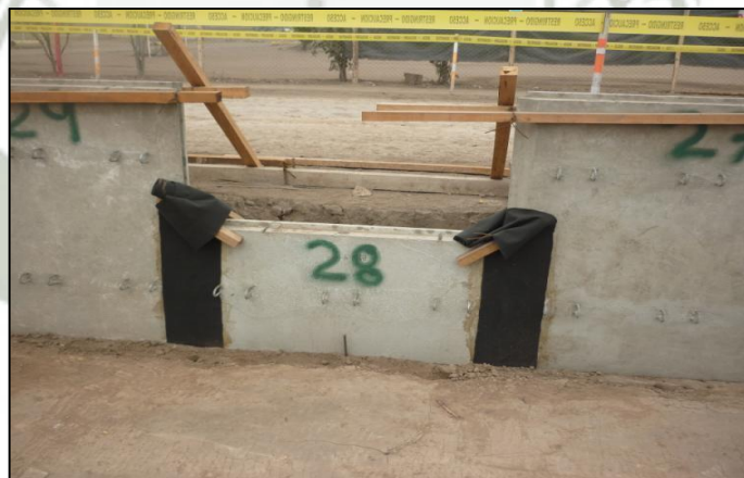
Figura 6-70. – Colocación de geotextil en las juntas entre paneles
