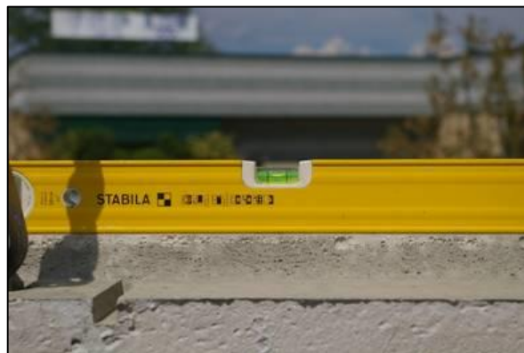
Figura 6-69. – Nivelado entre paneles prefabricados
