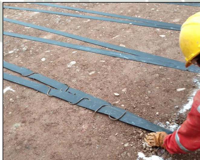
Figura 6-79. – Empalme en la parte final del refuerzo
