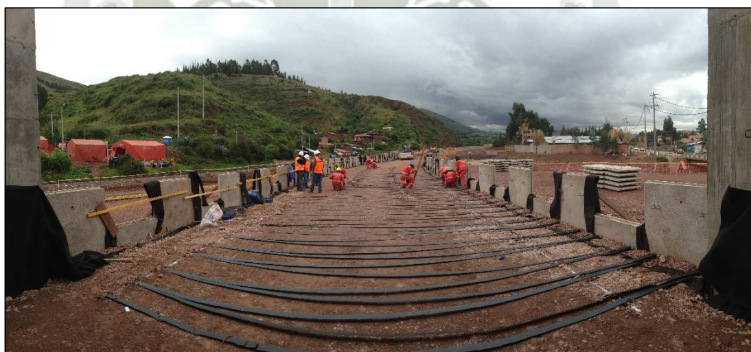
Figura 6-82. – Cintas poliméricas colocadas
