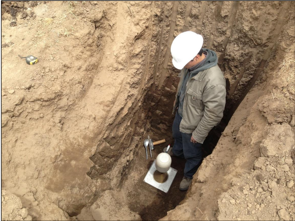
Figura A1.3 Ensayo del Cono de Arena
