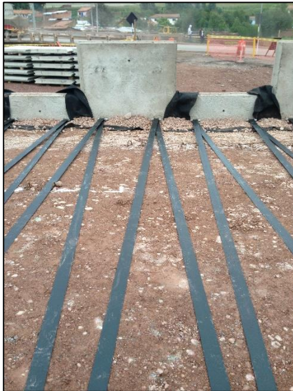
Figura 6-78. – Colocación del refuerzo pasando por los pasadores que se encuentran sujetos en las clavijas
