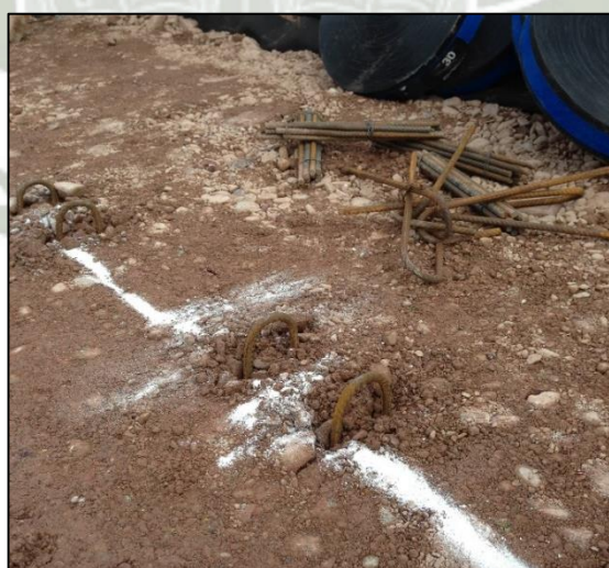
Figura 6-75. – Colocación de “J” en la marca donde finaliza el refuerzo
