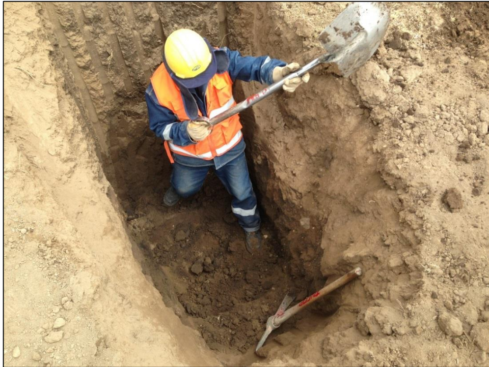
Figura A1.1 Excavación de Calicata
