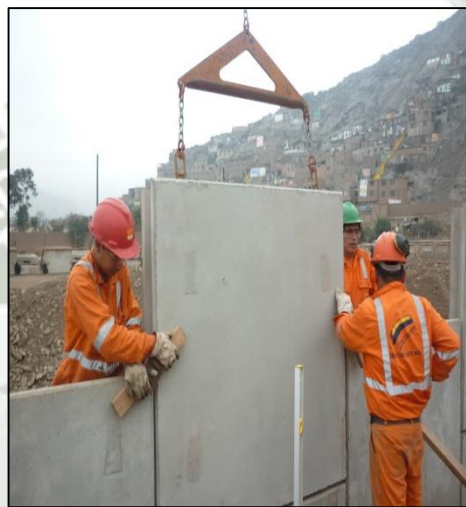
Figura 3-2. – Panel Prefabricado de Concreto
