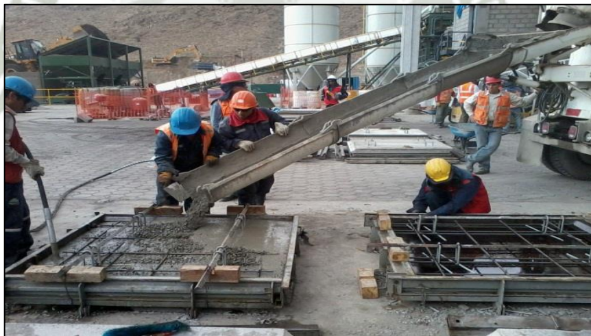
Figura 4-6. – Fabricación de Panel Segmentado de Concreto Prefabricado
