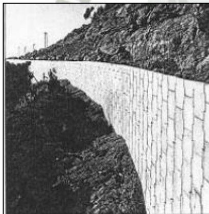
Figura 3-4. – Paramento Frontal Sistema de Paneles Segmentados (FHWA-NHI-10-024, 2009)
