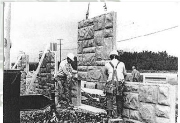
Figura 3-4. – Paramento Frontal Sistema de Paneles Segmentados (FHWA-NHI-10-024, 2009)
