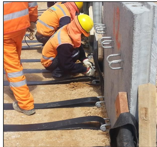
Figura 6-78. – Colocación del refuerzo pasando por los pasadores que se encuentran sujetos en las clavijas
