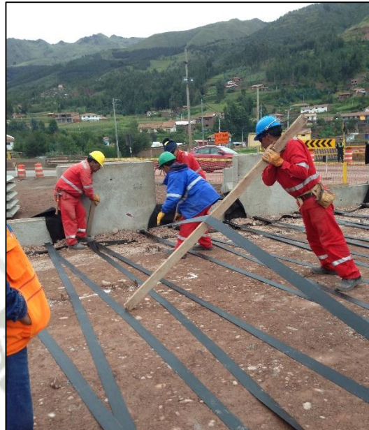
Figura 6-80. – Tensado de la cinta mediante una sección cuadrada de madera de longitud variable
