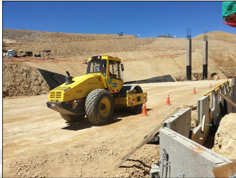
Figura 6-72. – Compactación del relleno estructural con equipo pesado
