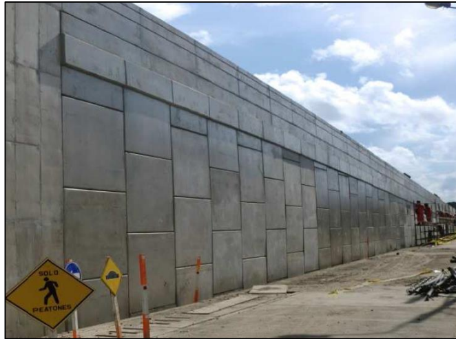
Figura 3-3. – Paramento Frontal Sistema de Paneles Segmentados
