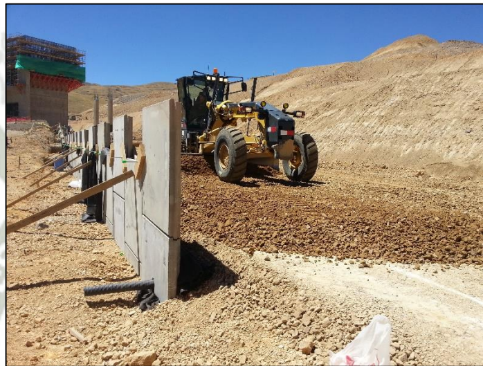
Figura 6-71. – Colocación y nivelación del relleno estructural
