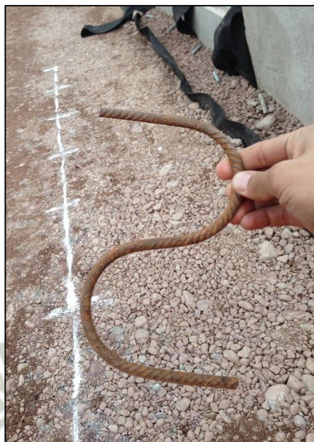
Figura 6-76. – Elemento de sujeción en empalmes “S”
